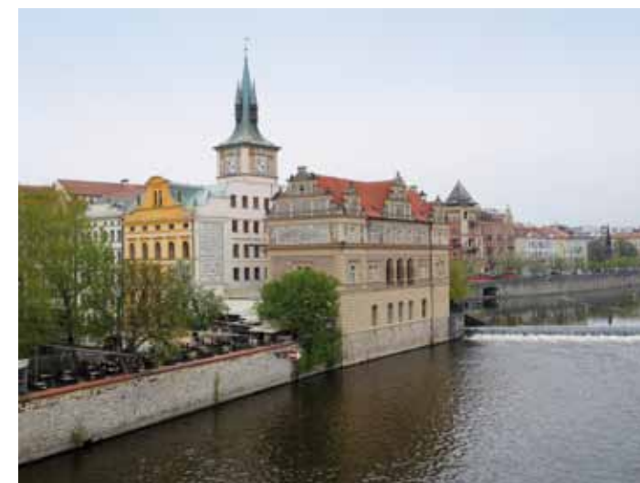
Obr. 4.191: Praha – čerpací stanice Staroměstské vodárny. Foto Michaela Ryškové, 2021.
