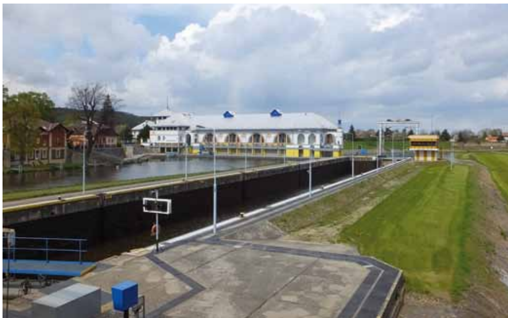
Obr. 4.187 MVE Miřejovice s plavební komorou. Foto Aleš Dráb, 2014.
