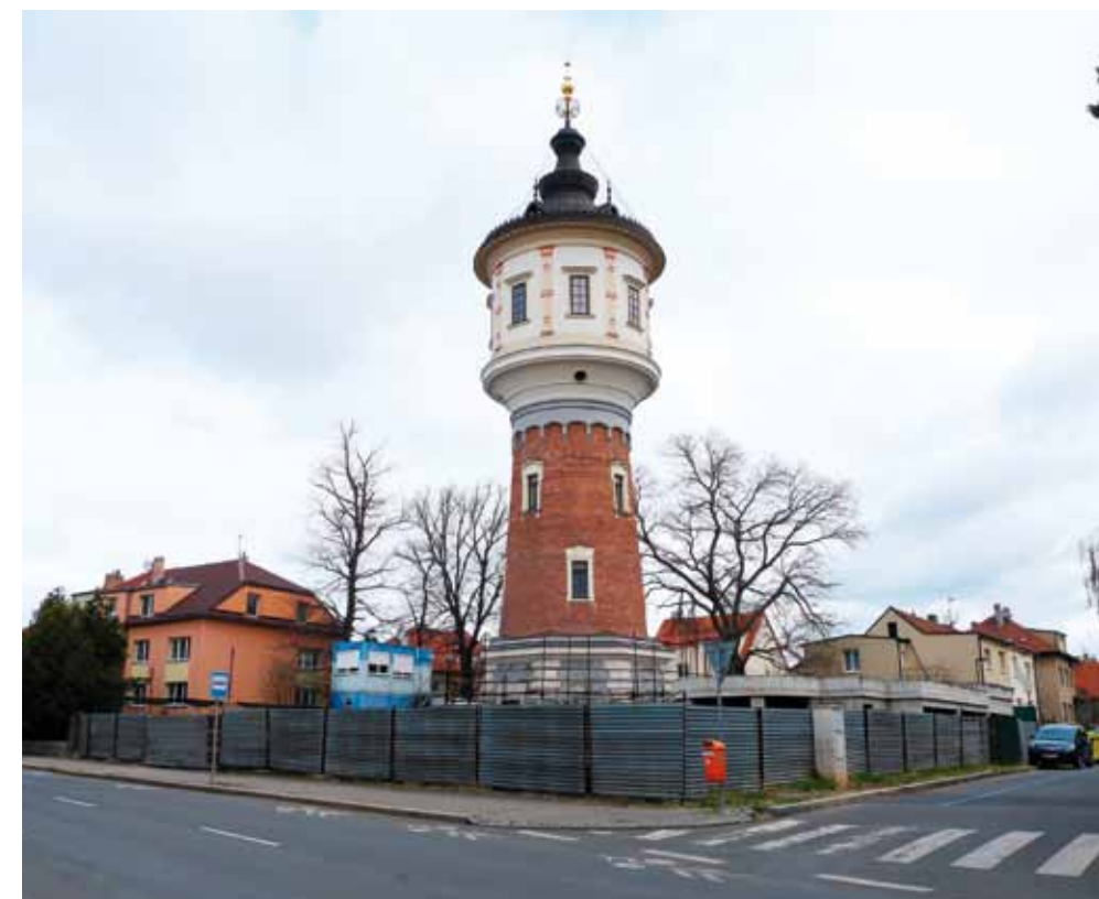
Obr. 5.22: Praha-Libeň – věžový vodojem na Mazance – po rekonstrukci a přestavbě na bydlení. Foto M. Ryšková, 2022.
