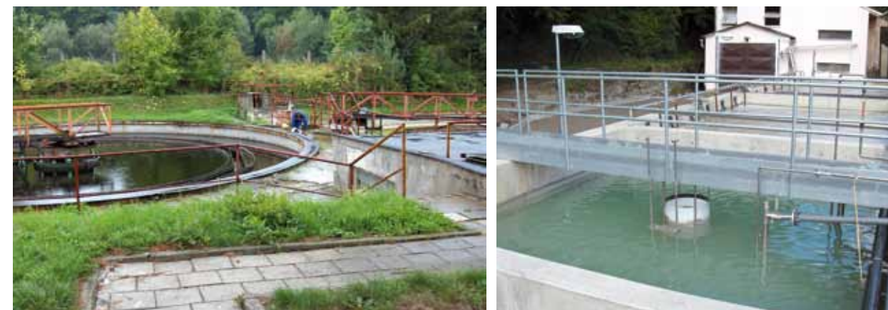
Obr. 4.253: Dosazovací nádrž. Foto archiv VÚV.
