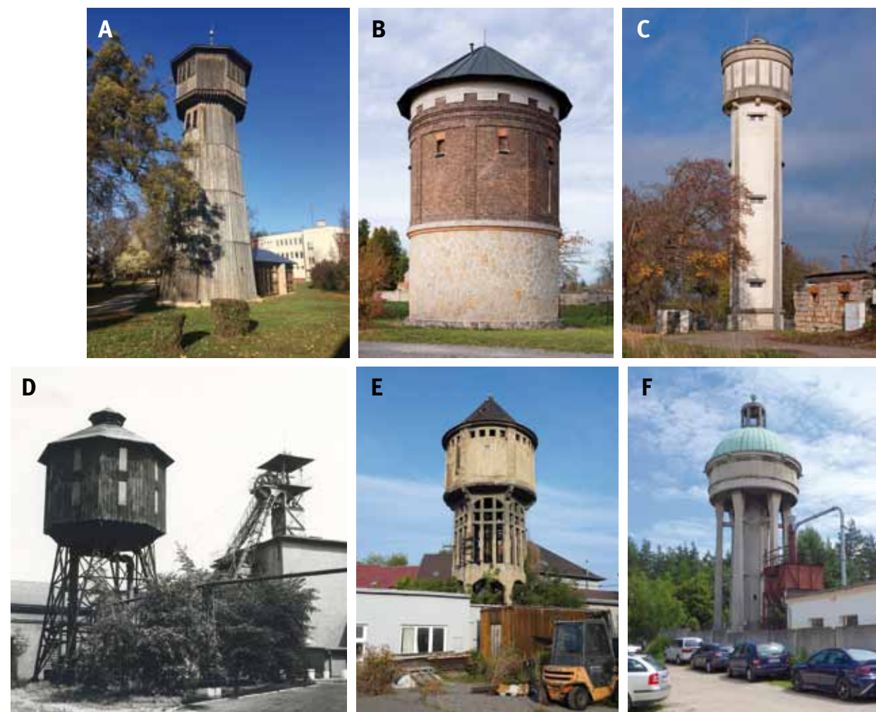
Obr. 4.217: Příklady nosných konstrukcí věžových vodojemů: (A) Palárikovo (Slovensko), dřevěný věžový vodojem, zřejmě jediný zachovalý v Evropě; (B) Kovanec, věžový vodojem se stěnovou nosnou konstrukcí zděnou z kamene a cihelného zdiva, postavený v historizujícím tovaroslouví podle návrhu Karla Kresse v roce 1909; (C) Horní Bukovina, věžový vodojem se železobetonovou nosnou konstrukcí postavený roku 1935 podle návrhu Ing. Fanty; (D) Ostrava, důl Hubert, zaniklý věžový vodojem s ocelovou nosnou skeletovou (příhradovou) konstrukcí a dřevěným opláštěním nádrže na snímku z konce 60. let 20. století; (E) Duchcov, věžový vodojem se skeletovou železobetonovou nosnou konstrukcí postavený v letech 1908–1912 pro sklárnu Engels; (F) Lázně Bohdaneč, věžový vodojem nesený železobetonovou kombinovanou konstrukcí, postavený podle návrhu Josefa Gočára v roce 1911; ve středním dílku je umístěno schodiště. Foto (A), (E) a (F) Michaela Ryškové, 2021, 2020 a 2016; (B) a (C) Viktor Mácha, 2018; (D) archiv NPÚ, MCPD.
