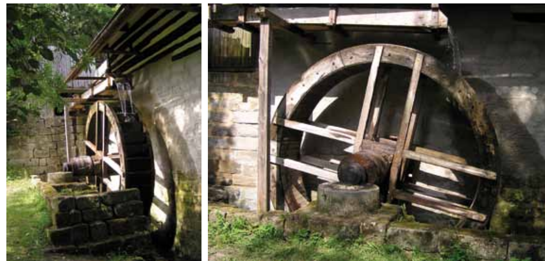
Obr. 4.165: Střehom (okr. Mladá Boleslav), mlýn čp. 12 – korečník na vrchní vodu. Foto Radim Urbánek, 2006.
