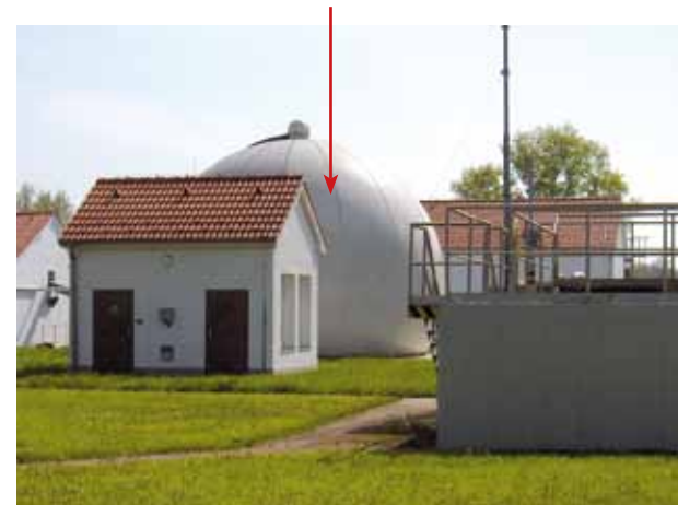
Obr. 4.256: Kalové hospodářství na ČOV – vyhnívací nádrže s bioplynem (převzato z: archiv VÚV).
