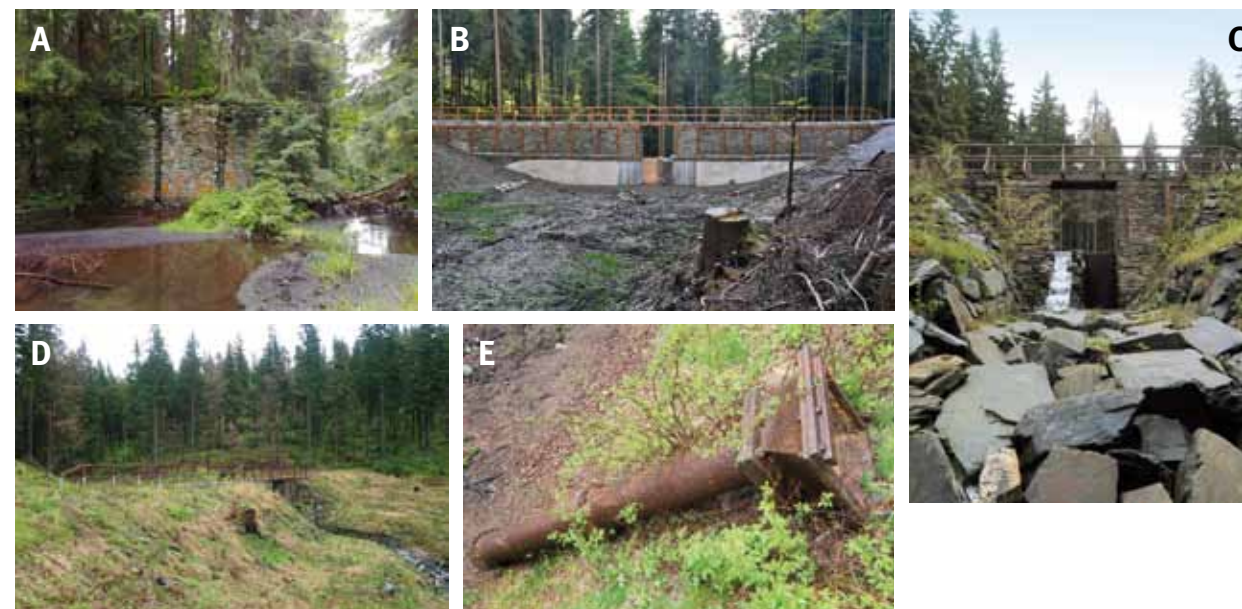
Obr. 5.11: Stará Ves, Žďárský Potok – obnova klauzy na Splavském potoce: (A) zbytky původní hráze; (B) opravená hráze z návodní strany; (C) střední část hráze s průtočnou sekci; (D) celkový pohled na hráze ze vzdušné strany; (E) původní odtokové potrubí. Foto (A) a (B) převzato z: Rymarovsko, 2021; (C), (D) a (E) Martin Caletka, 2021.
