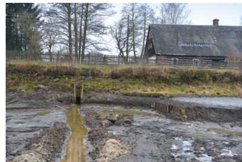
Obr. 4.64: Markvartice u Jablonného v Podještědí, Markvartický rybník – spodní výpusť jalového odtoku s požerákem, návodní líc s typickým opevněním z pískovcových kvádrů, stav po vypuštění rybníka. Foto Miroslav Kolka, 2014.
