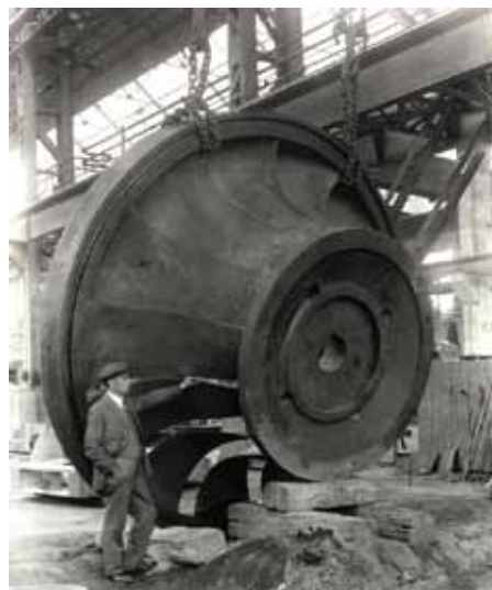
Obr. 4.178: Výroba oběžného kola Francisovy turbíny pro MVE Miřejovice (přezato z: firemní materiály ČKD Blansko).
