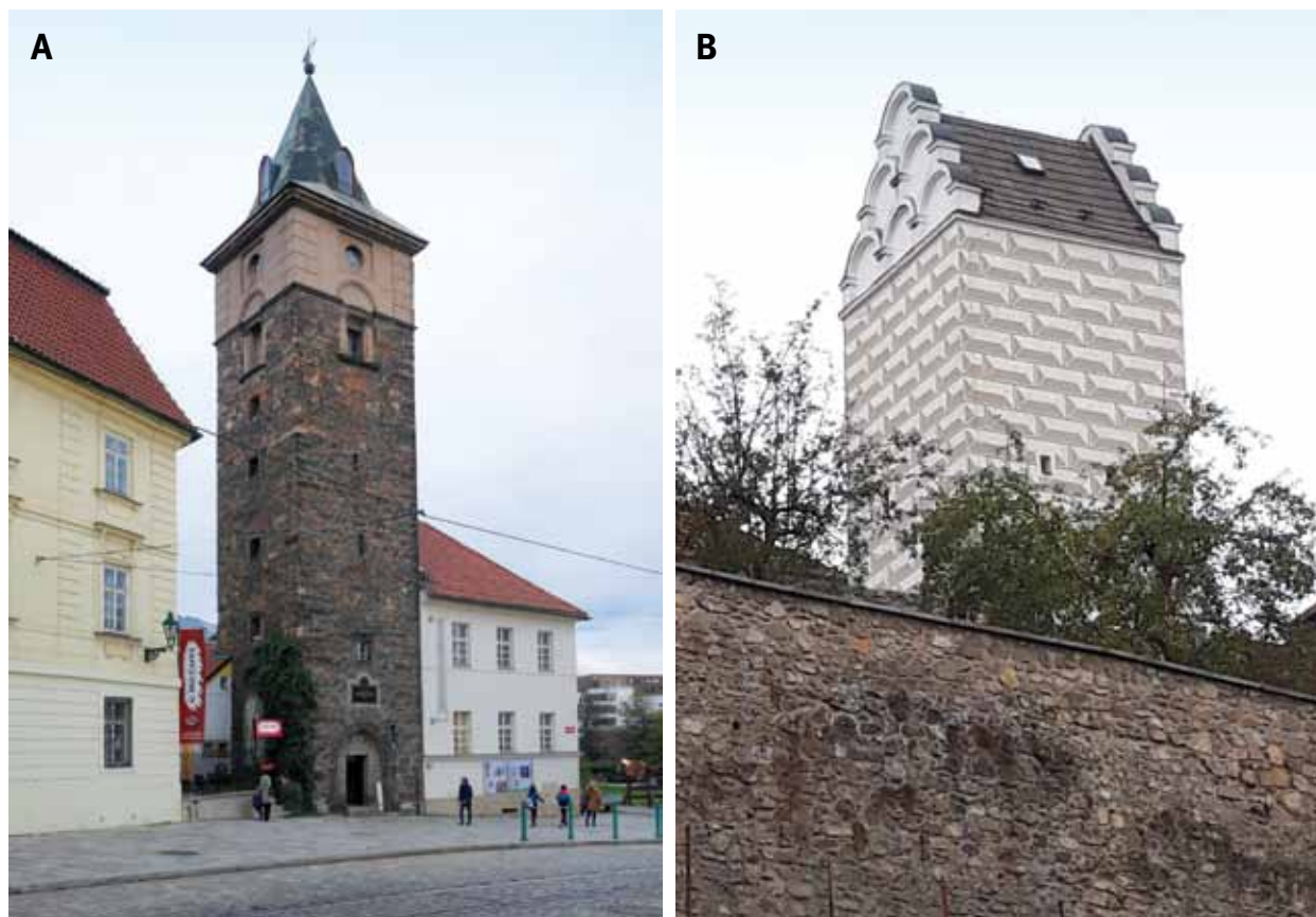
Obr. 3.9: Vodárenské věže: (A) Plzeň, pozdně gotický věžový vodojem z kamenného zdiva, zmiňovaný poprvé roku 1532. Klasicistní objekt čerpací stanice (upravo) byl postaven z kamene ze zbořených Pražských bran. Gotizující tvar střechy věže pochází zřejmě z roku 1845, kdy byla zvýšena při přestavbě provedené stavitelem Kristiánem Lexou. V roce 1843 byla v nejvyšším patře měděná nádrž o objemu 2,7 m 3 . Čerpací stanice byla vybaena okovaným vodním kolem a tříválcovou pumpou a čerpala vodu z řeky. Vstupní portál osazený v 19. století pochází z městského domu (Hlušíčková 2003). (B) Tábor, renesanční podoba věže se sgrafitovými psaníčky a obloučkovými štíty vznikla po požáru v roce 1559. Město zásobovala údolní nádrž Jordán (z roku 1492), pod jejíž hrází stála čerpací stanice s dřevěným čerpadlem poháněným vodním kolem, které vytlačovalo vodu potrubím do věže zásobující městské kašny (Vávra 1913). Dnes je v objektu galerie. Foto (A) Alena Borovcová, 2020; (B) Eva Dvořáková.
