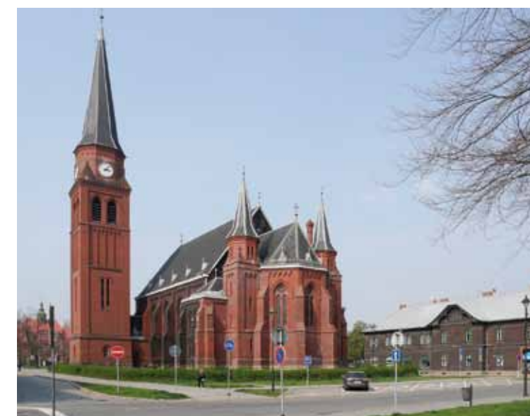
Obr. 4.221: Ostrava-Vítkovice – unikátní věžový vodojem ve věži kostela sv. Pavla v Ostravě-Vítkovicích. Město Nové Vítkovice, založené Vítkovickými železárnami jako zázemí pro rozrůstající se výrobní provozy, bylo budováno od 70. let 19. století. Součástí a významnou dominantou jeho náměstí se mimo radnice stal také kostel sv. Pavla se samostatně stojící věží. Ta byla vystavěna ještě před vlastní chrámovou lodí v roce 1882 a v její horní části byly mimo zvonice a požární pozorovatelný umístěny také dvě nádrže, každá o objemu 50 m 3 . Byly součástí vodovodního systému, na který byly napojeny obytné soubory a další stavby nově budovaného města (Matěj a kol., 1992). Foto Michaela Ryškové, 2019.
