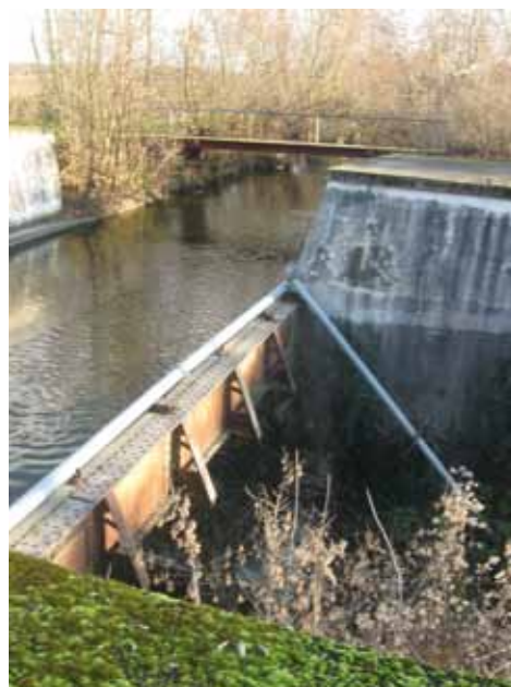
^ Obr. 4.92: Semínský akvadukt na Opatovickém kanále: (A) stav po rekonstrukci; (B) pozůstatky starých dřevěných proků. Foto David Honek, 2020.
