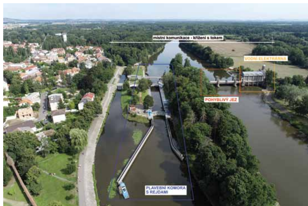
Obr. 4.120: Stupeň Poděbrady – proky funkčního celku. Foto Radek Bachan, 2021.
