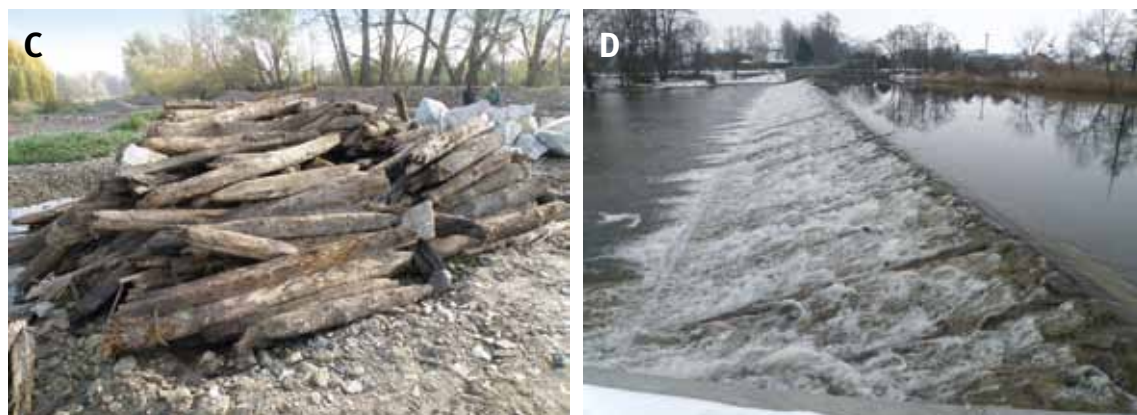
Obr. 5.5: Znojmo-Oblekovicce – rekonstrukce jezu v Oblekovicích na řece Dyji: (C) původní části dřevěné trémové konstrukce; (D) rekonstrukce dokončena, leden 2019. Foto Miriam Dzuráková, 2018–2019.
