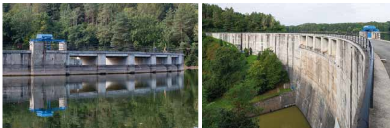
Obr. 4.21: Přehrada Vrhlíče (1966–1970) – klenbová přehrada. Foto Viktor Mácha, 2020.
