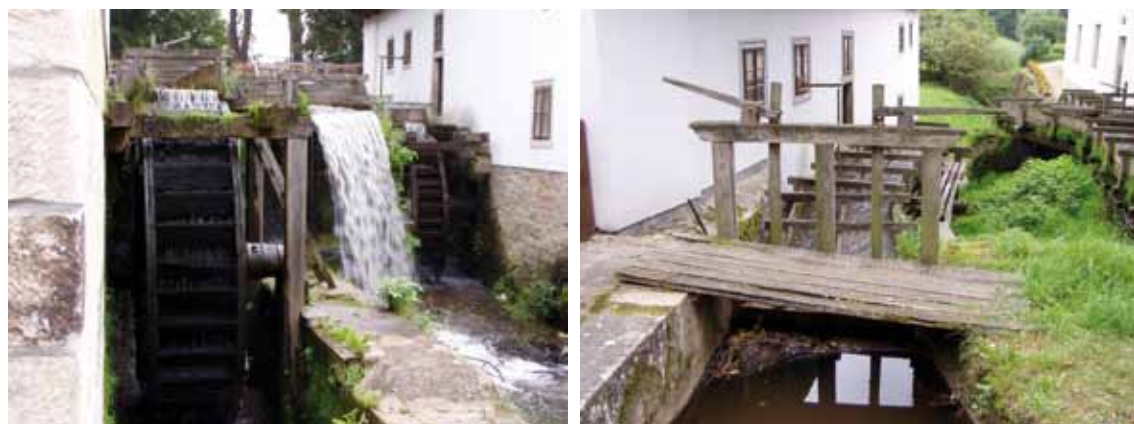
Obr. 4.89: Ratibořice – dřevěné proky náhonu u mlýna v Babiččině údolí. Foto Milena Forejtníková, 2010.
