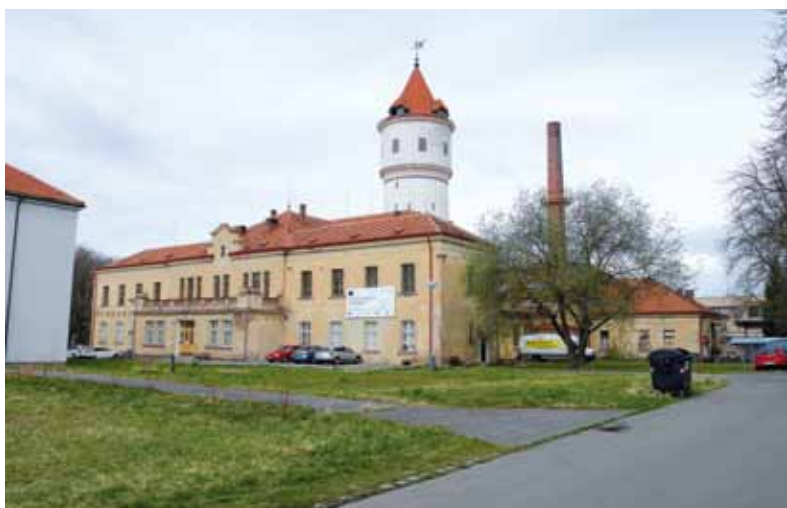
Obr. 4.195: Praha-Bohnice (Psychiatrická léčebna Bohnice) – blok prádelny čp. 25. Rozsáhlý areál psychiatrické léčebny vznikl od roku 1905 do 30. let 20. století. Autor většiny staveb Václav Roštlapil projektoval také věžový vodojem z roku 1908. Studená užitková voda byla čerpána do nádrže v nejvyšším patře, pod ní byly doře expanzní nádrže pro regulaci tlaku topné soustavy, níže nádrž na teplou vodu a dole na vodu ovládnou, vedenou do lázní. Studená voda tekla samospádem dolů, kde byla ohřata párou, a sama stoupala do nádrže na teplou vodu, odkud byla rozváděna samospádem do areálu. Vodárna sloužila do roku 1972. Budova původní čerpací stanice byla přebudována na bytovou jednotku. Foto Michaela Ryškové, 2022.
