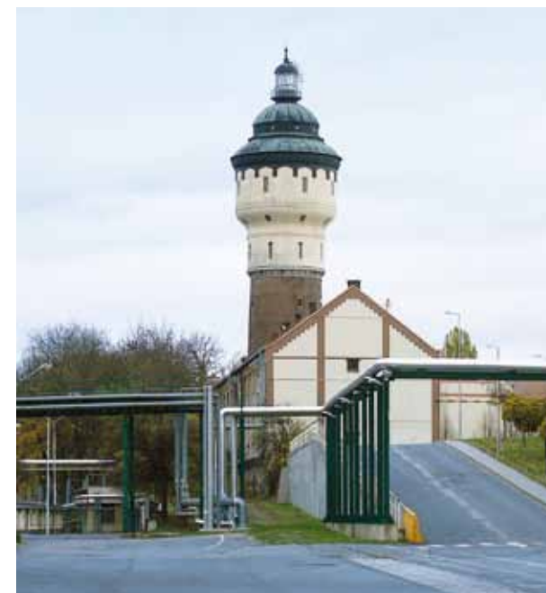
Obr. 4.196: Plzeň – věžový vodojem v areálu pivovaru Prazdroj z let 1905–1907 byl součástí vodovodu Měšťanského pivovaru. Prováděcí projekt zpracoval ing. Spalek a stavitel Hucl. Doře železné nádrže byly usazeny nad sebou, jedna na pramenitou a druhá na říční vodu. Systém vodárny sestával vedle věžového vodojemu z elektrárny pohánějící říční čerpací stanici, objektu hrubého filtru, odželezovací stanice a pračky písku a vodárenské budovy u studny na Roudné. Foto Alena Boroucová, 2020.
