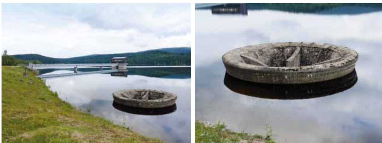
Obr. 4.30: Přehrada Josefův Důl (1976–1982) – zemní sypaná hráz, šachtový bezpečnostní přeliv. Foto Michaela Ryšková, 2020.
