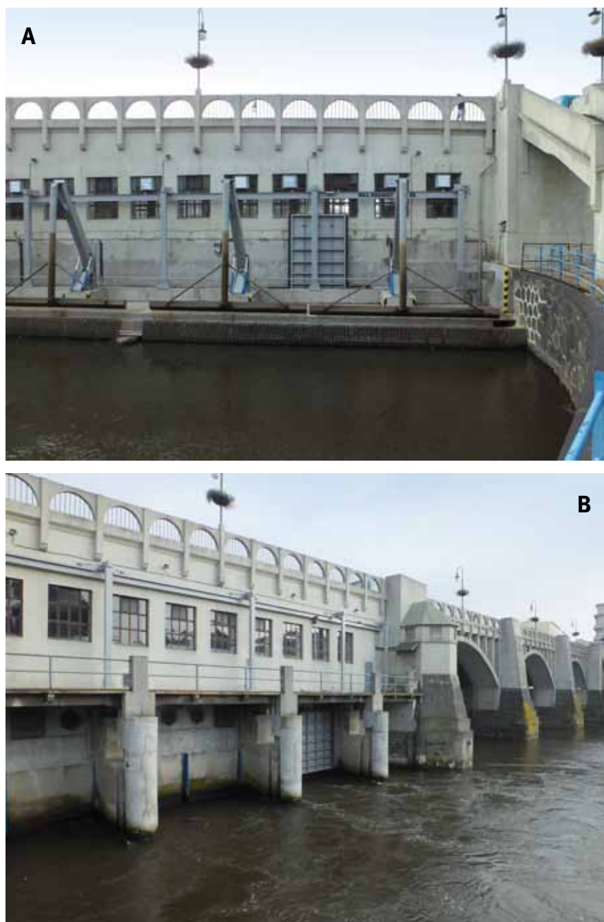
Obr. 4.141: MVE Kolín: (A) vtokový objekt; (B) výtokový objekt. Foto VUT v Brně, FAST, 2015.
