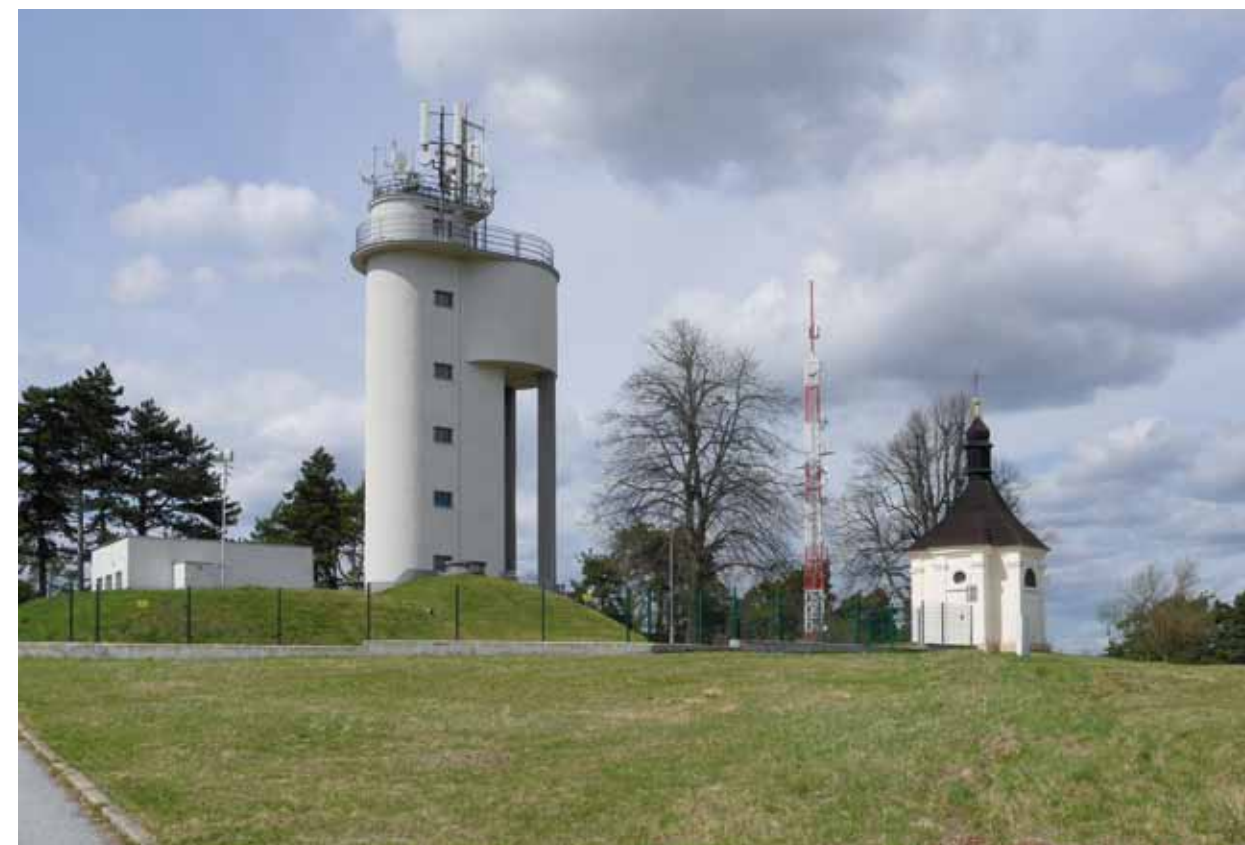
Obr. 5.24: Třebíč – věžový vodojem Kostelíček. Foto Michaela Ryškové, 2022.
