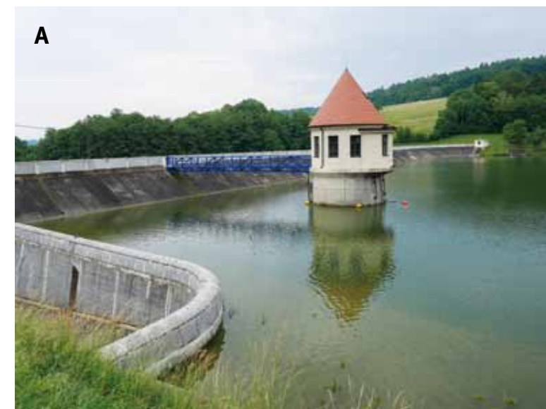
Obr. 4.208: Samostatně stojící sdružené objekty pro odběry vody z nádrží: (A) Přehrada Fryšták – samostatně stojící sdružený objekt úpustí a vodárenských odběrů se strojovou pro ovládání uzávuěrů úpustí v horní části. Odběr vody zajišťují dvě potrubí ve dvou úrovních. Součástí vodního díla je také úprava, situovaná pod hrází přehrady. (B) Vodní dílo Švihov – zdroj surové vody pro úpravu vody Želivka. Samostatně stojící sdružený odběrný objekt hráze. Odběr vody je zajištěn dvěma odběrnými pilíři s možností pěti etážových odběrů, sahající až na dno nádrže, zakončenou v koruně nouzovým přepadem. Voda je vedena do čerpací stanice u paty nádrže a dále do úpravy vody (Parkán a Pěkný, 2012). Foto (A) Michaela Ryšková, 2020; (B) Archiv PVK.
