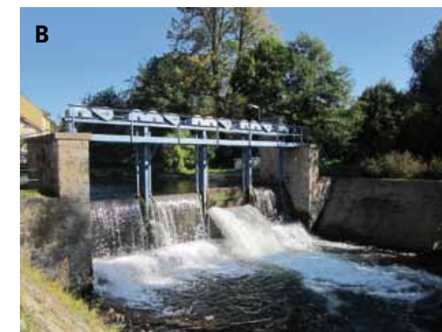
Obr. 4.108: Stavidlový jez: (A) stavidlový (tabulový) jez zdvižný; (B) Hronov, stavidlový jez na Metuji. Schéma Radka Račoch a Radek Bachan, 2021 (upraveno dle: Gabriel a kol., 1989); foto Eva Nesnídalová, vodnimlynny.cz, 2013.
