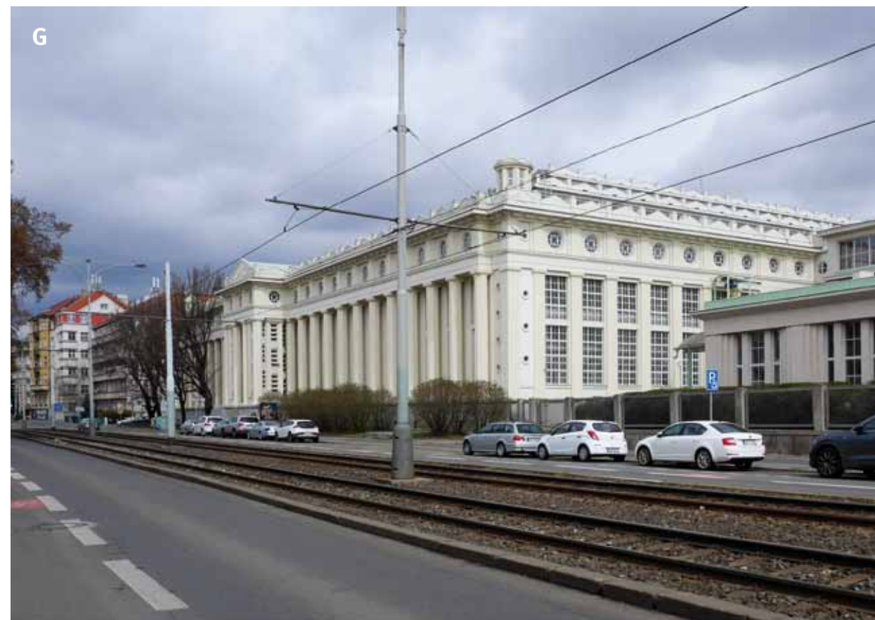
Obr. 4.233: Praha – úprava vody Podolí: (A) hala filtrace z let 1923–1929 ve 30. letech 20. století; (B), (C) a (D) hala filtrace se současnými filtračními nádržemi; (E) a (F) hala čičů z let 1952–1965; (G) průčelí haly filtrace. Foto (A) – (F) Archiv PVK a Jaroslav Beneš, 2018; (G) Michaela Ryšková, 2021.
