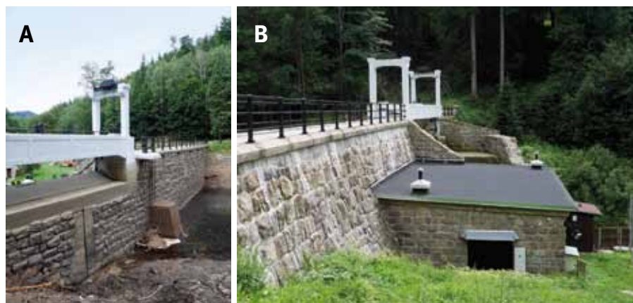
Obr. 4.132: MVE Rudolfův II: (A) návodní líc hráze s utokovým objektem; (B) strojovna MVE. Foto Michaela Ryškové, 2021.
