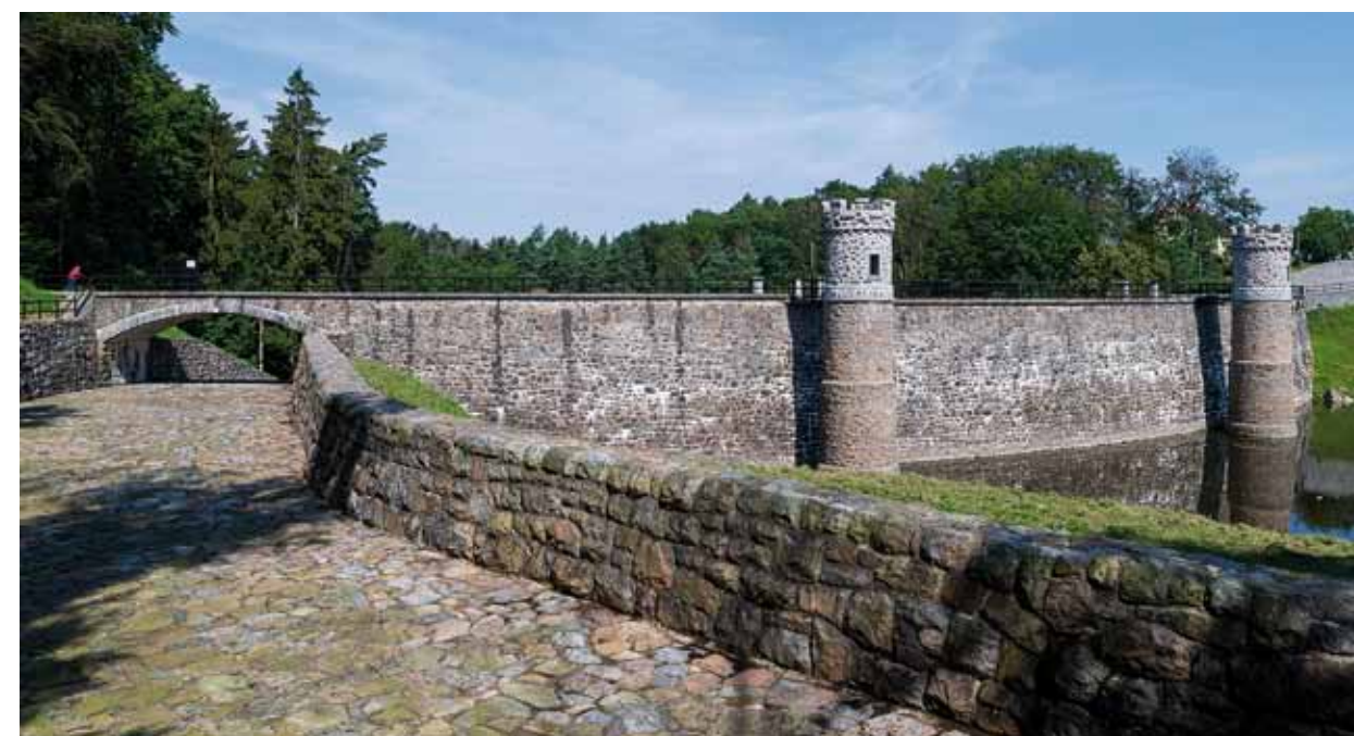
Obr. 4.11: Přehrada Pařížov (1909–1913) – přelivná hrana bočního bezpečnostního přelivu a spadiště, které za mostem navazuje na kaskádu. Foto Viktor Mácha, 2020.
