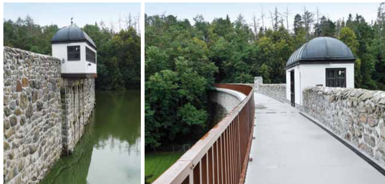
Obr. 5.25: Přehrada Jevišovice – objekt pro ovládání spodních výpustí. Foto Michaela Ryškové, 2020.
