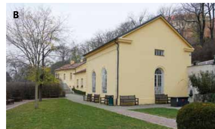
Obr. 3.10: Parní čerpací stanice v Opavě (A) a Brně (B) nesou architektonické formy charakteristické pro tento typ objektů. Jedná se o přízemní stavby se sedlovou střechou a zaklenutými okny. Foto (A) Alena Borovcová; (B) Michaela Ryšková, 2021.
