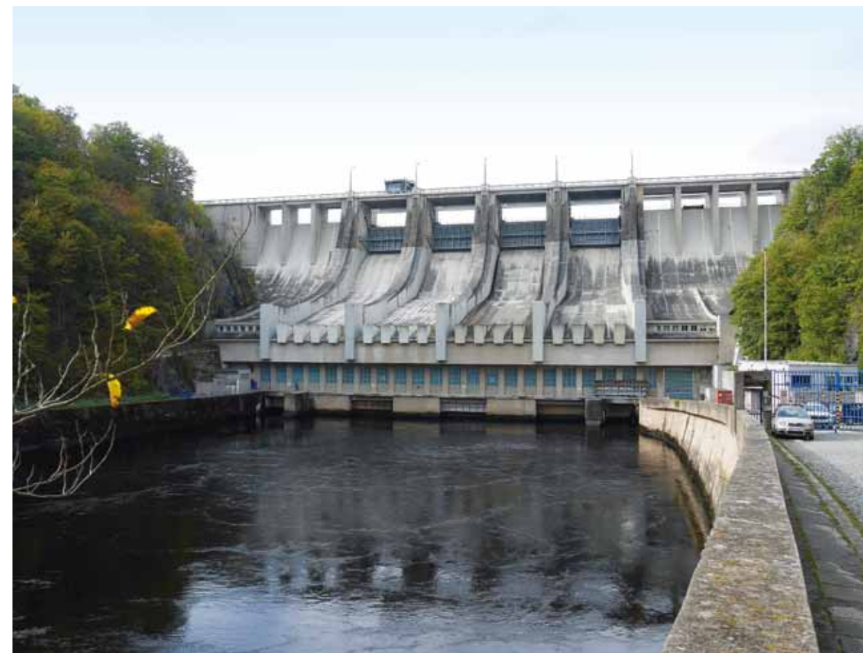
Obr. 4.41: Přehrada Slapy (1949–1957) – tížná betonová přehrada, korunový bezpečnostní přeliv o čtyřech polích hrazený zdvižným segmentem. Foto Viktor Mácha, 2021.
