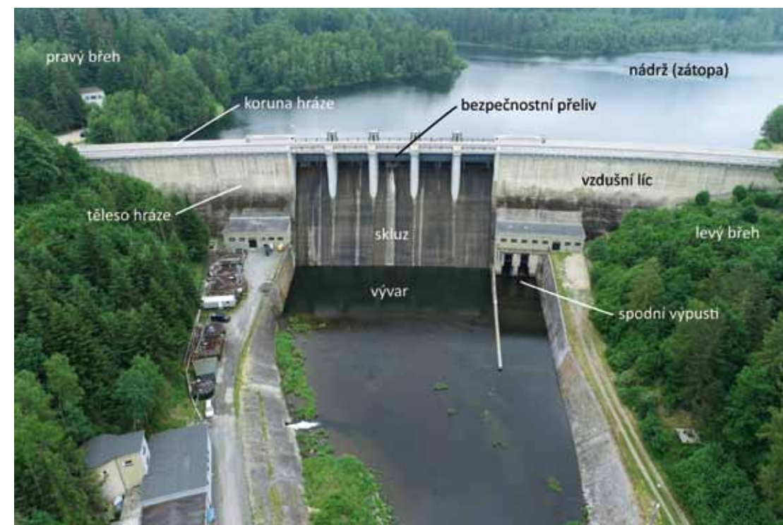
Obr. 4.1: Vymezení základních pojmů – přehrada Kružberk (1948–1955). Foto Radek Bachan, 2021.
