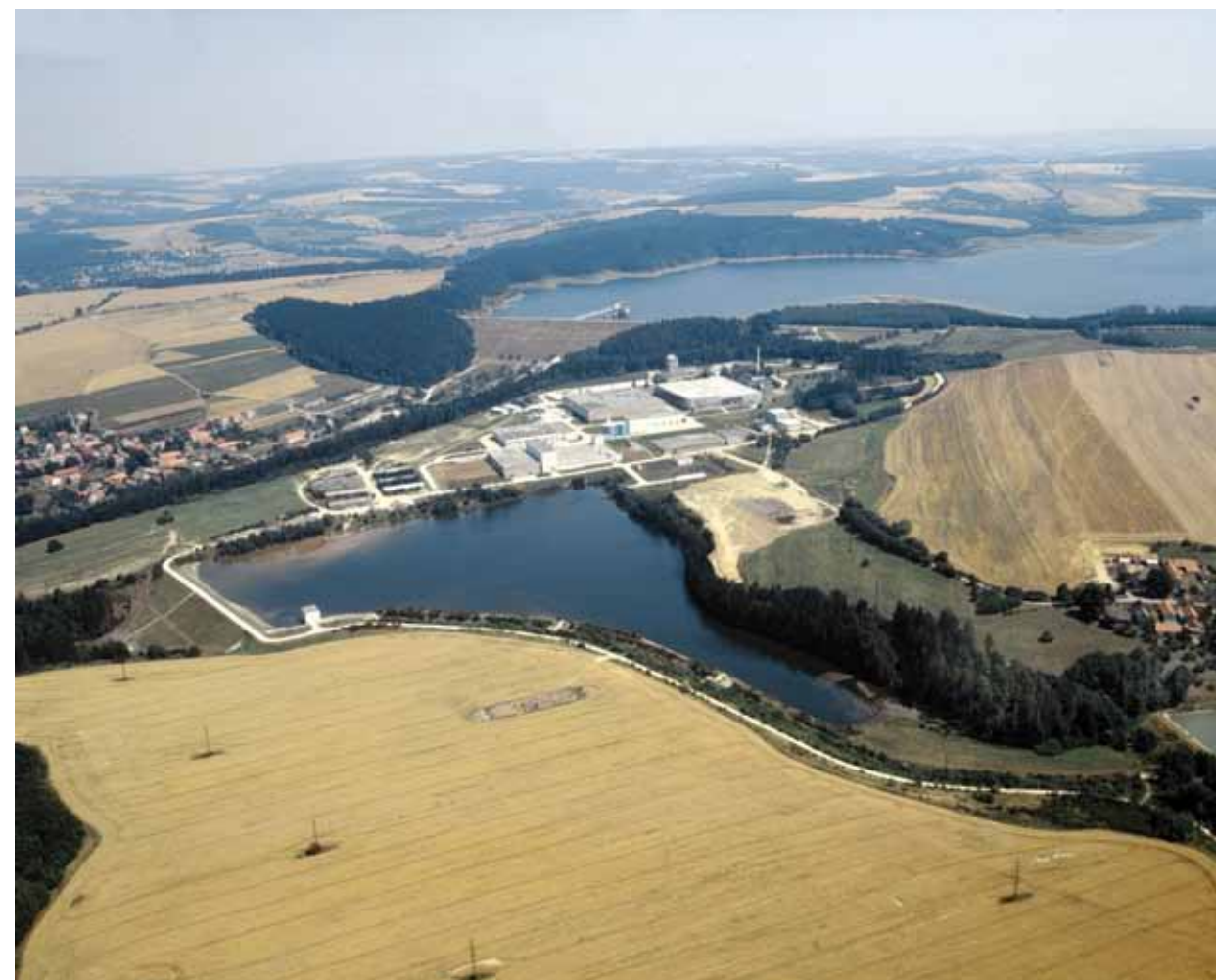
Obr. 4.229: Švihov – letecký pohled na úpravnu vody Želivka. Foto Archiv PVK, f. Fotoarchív PVK, kt. N 17, sign. B 180/00.
