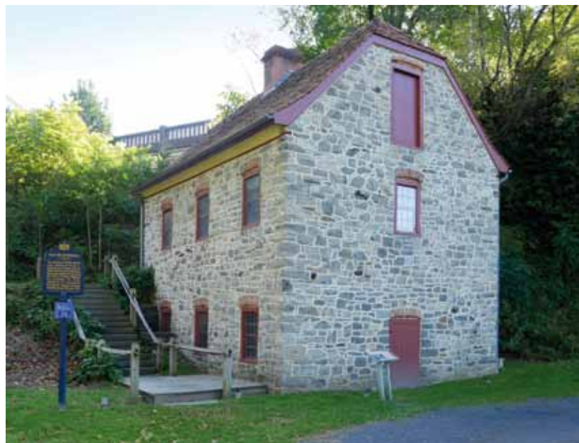
Obr. 3.23: Bethlehem (USA) – čerpací stanice. Evropské raně moderní systémy zásobování vodou 16. a 17. století na principu vzdáleného gravitačního napájení s čerpadly poháněnými vodními koly byly přeneseny do Ameriky. Za nejstarší čerpací stanici vody v USA je považována stanice vybudovaná v roce 1754 pro potřeby městečka Bethlehem, založeného přistěhovanci tzv. Moravské komunity. Voda byla čerpána z pramene do vodárenské věže a odtud proudila gravitačně do pěti cisteren a nádrží. V budově na snímku pracovala čerpací stanice do roku 1832. (Douet, 2018). Foto Michaela Ryškové, 2018.
