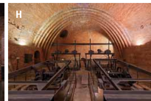
Obr. 4.269: Praha-Bubeneč – Stará čistírna odpadních vod: (D) celkový pohled; (E) stavidloový uzávěr na stoce; (F) lapák písku; (G) kotelna a uhelna pro výrobu teplé vody a vytápění (původně prostor nádrží na vápennou vodu); (H) česle. Foto Viktor Mácha, 2019.
