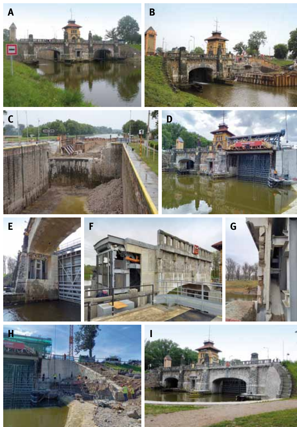
Obr. 5.4: Hořín – zdymadlo v průběhu rekonstrukce: (A) stav před přestavbou; (B) a (C) rozebírání původních konstrukcí a kamenných obkladů; (D) až (F) nová konstrukce zvedacího mostu a velké plavební komory; (G) a (H) osazování původního obkladu na novou železobetonovou konstrukci. Foto (A) – (H) Otakar Hrdlička, 2019–2021; (I) Michaela Ryšková, 2021.
