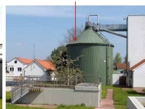
Obr. 4.256: Kalové hospodářství na ČOV – vyhnívací nádrže s bioplynem (převzato z: archiv VÚV).
