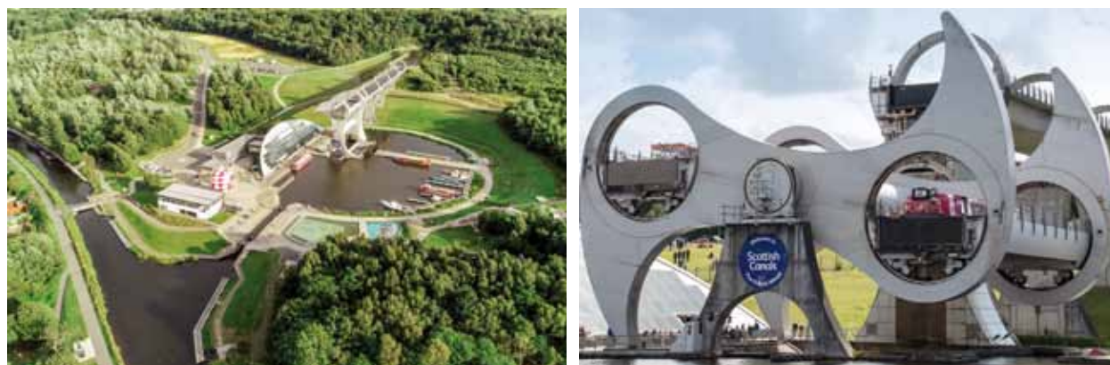
Obr. 4.82: Falkirk (Velká Británie, Skotsko) – rotační lodní zdvihač. Foto Shutterstock.
