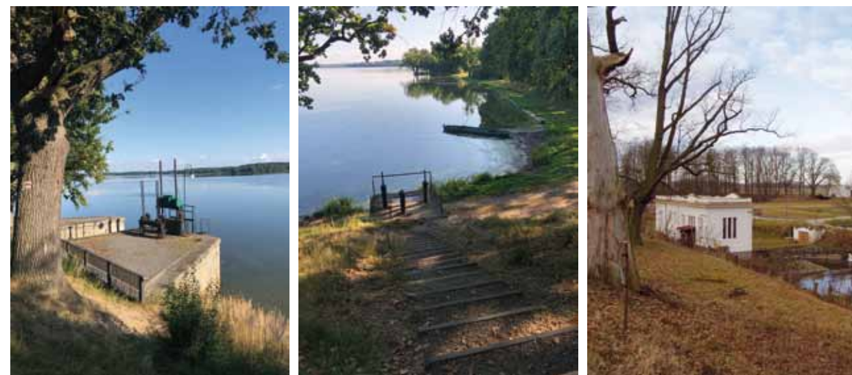
Obr. 4.72: Rybník Rožmberk a malá vodní elektrárna vybudovaná při rybníku Rožmberk v roce 1922. Foto Eva Dvořáková, 2006.
