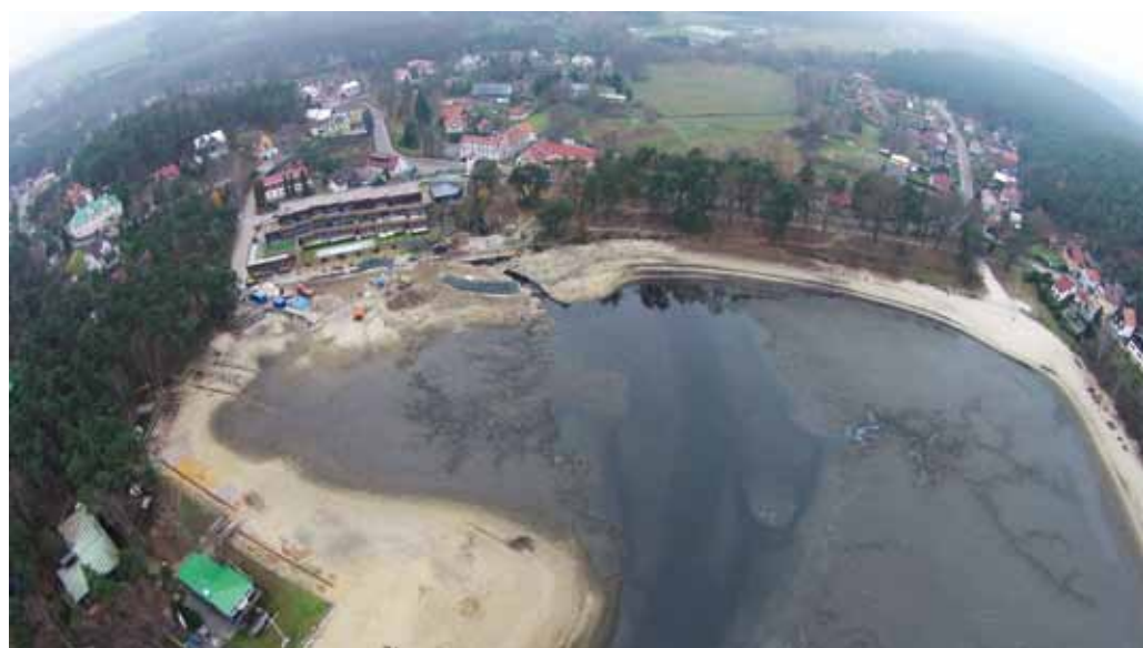
Obr. 4.50: Doksy – Staré Splavy, Máchovo jezero – v levé části snímku přímá hráz rybníka, kterou tvoří výchoz skalního pískovcového podloží s čedičovou žílou, ve střední části výpustní průrva, stav při přestavbě výpustního zařízení a vypuštění rybníka. Foto A. Kopecký, 2014.
