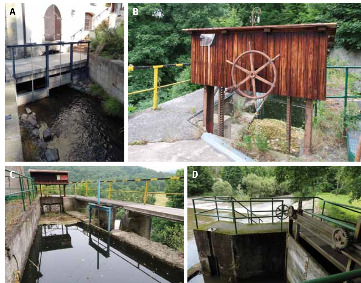
Obr. 4.94: Detaily ovládacích objektů: (A) Chrudim, dřevěná, ručně ovládaná stavidla; (B) Weissshuhnovův kanál, stavidlo ovládané původně ručně přebudované na elektropohon; (C) tamtéž, pravobřežní jalový odtok ovládaný hydraulicky; (D) mechanismus pro ruční ovládní stavidel z boku. Foto Radka Račoch, 2021.
