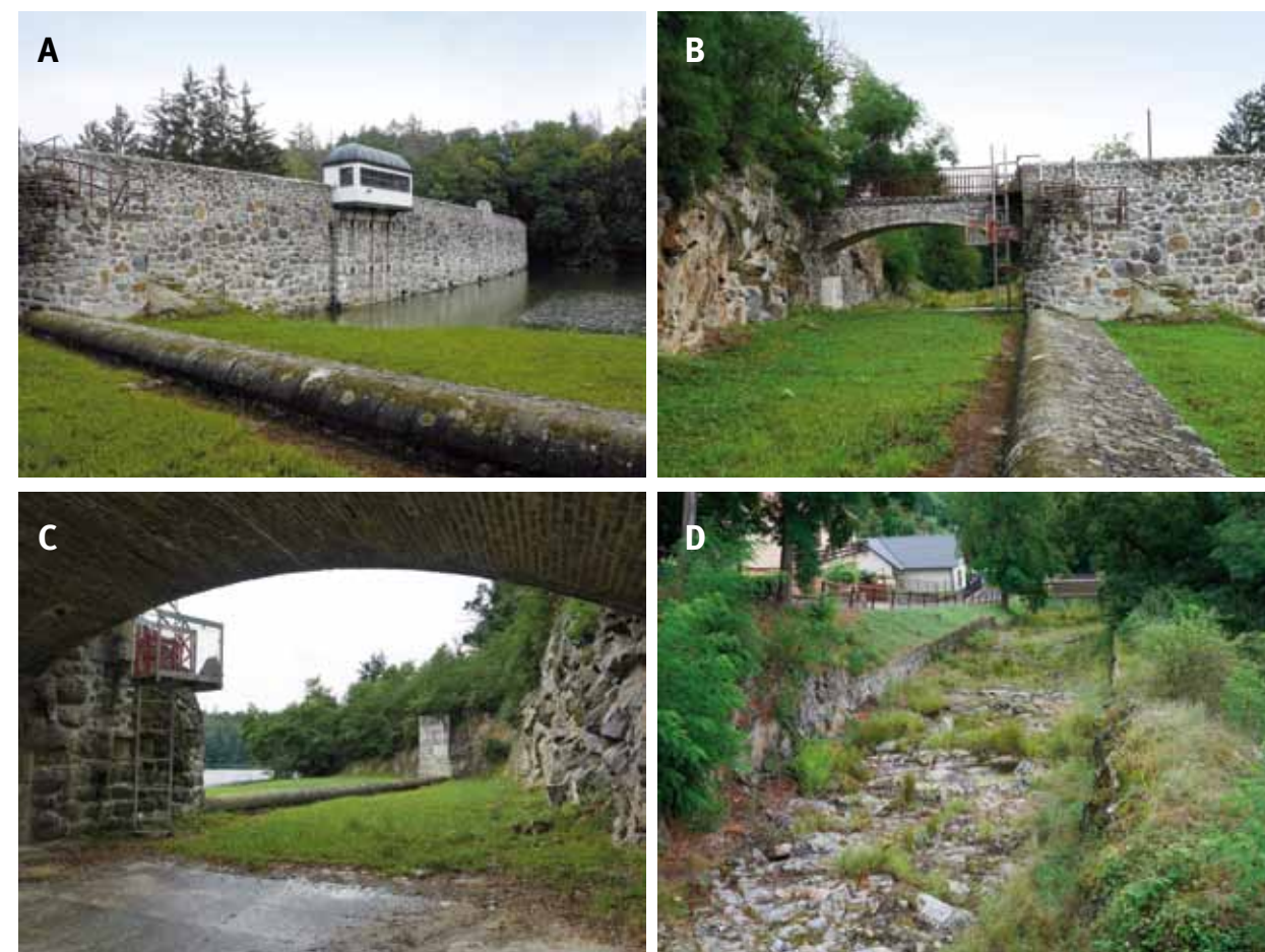
Obr. 4.28: Přehrada Jevišovice (1884–1896) – zděná tížná přehrada: (A) přelivná hrana nehrazeného bočního bezpečnostního přelivu; (B) přelivná hrana a spádiště; (C) pohled do spádiště zpod mostu; (D) skluz. Foto Michaela Ryšková, 2020.
