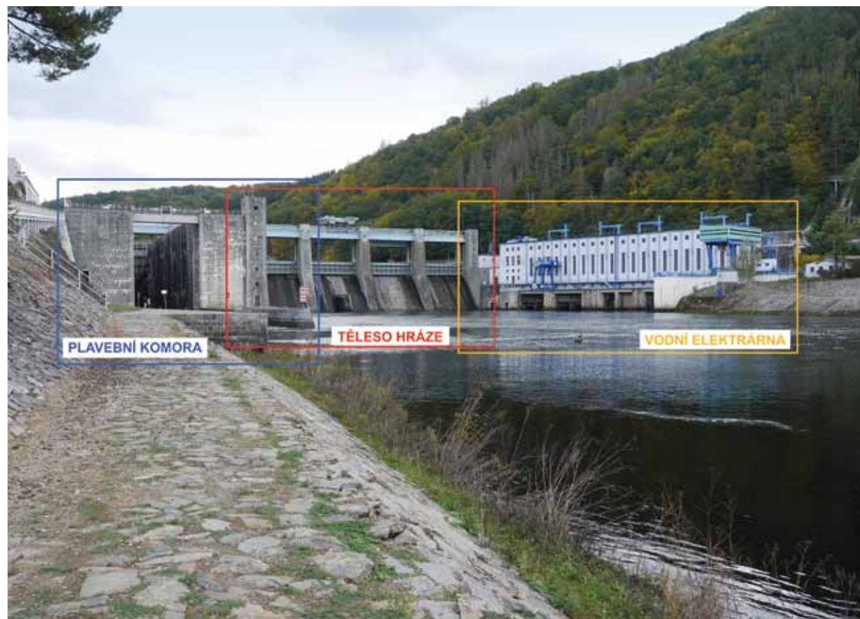
Obr. 4.35: VD Štěchovice (1937–1945) – tížná betonová hráz. Ukázka funkčního celku – přehrada + plavební komora + vodní elektrárna. Foto Michaela Ryškové, 2020.
