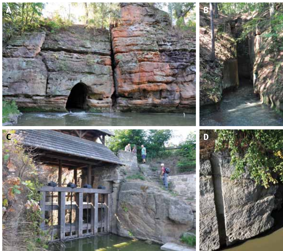
Obr. 4.90: Stavební materiál vodních kanálů – pískovec: (A) a (B) Průroa Ploučnice, umělé zkrácení toku tunelem a otevřeným korytem; (C) osazení objektu se stavídlý přímo do pískovcového skalního bloku; (D) detail drážky pro provizorní hrazení vysekané v pískovci. Foto David Honek, 2019.
