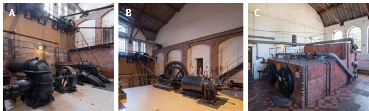
Obr. 4.269: Praha-Bubeneč – Stará čistírna odpadních vod: (A) a (B) strojoona parních strojů; (C) kotelna. Foto Viktor Mácha, 2019.
