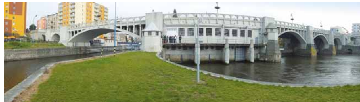
Obr. 4.131: MVE Kolín – pohled z prostoru podjezí na strojovnu a výtokovou část MVE (vlevo) a 3 pole válcového jezu (vpravo). Foto VUT v Brně, FAST, 2014.
