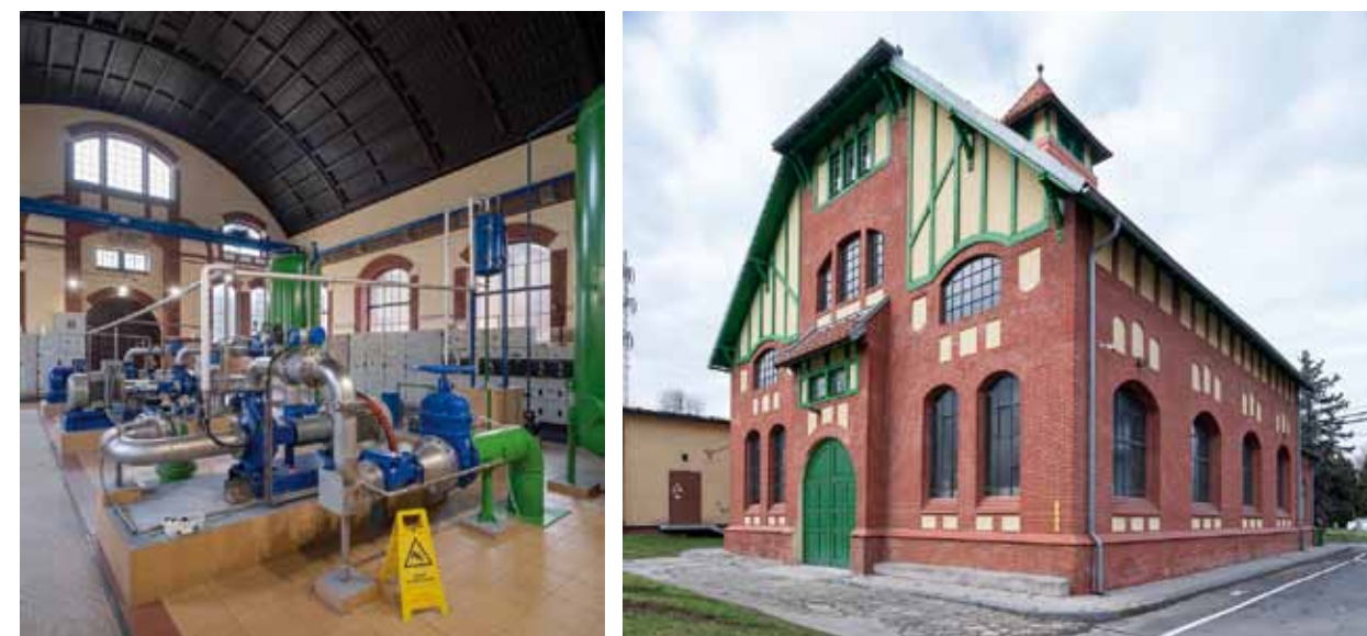
Obr. 5.2: Ostrava – úpravna vody, strojovna. Foto Viktor Mácha, 2019.
