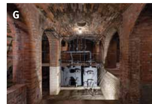
Obr. 4.269: Praha-Bubeneč – Stará čistírna odpadních vod: (D) celkový pohled; (E) stavidloový uzávěr na stoce; (F) lapák písku; (G) kotelna a uhelna pro výrobu teplé vody a vytápění (původně prostor nádrží na vápennou vodu); (H) česle. Foto Viktor Mácha, 2019.
