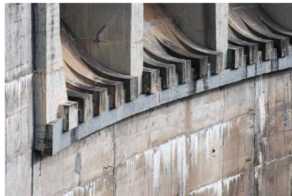
Obr. 3.16: Přehrada Vrchlice (1966–1970) – rytmizovaný detail rozrážeců vody korunového přelivu kontrastuje s monumentální plochou vzdušného líce betonové hráze. Foto Viktor Mácha, 2020.
