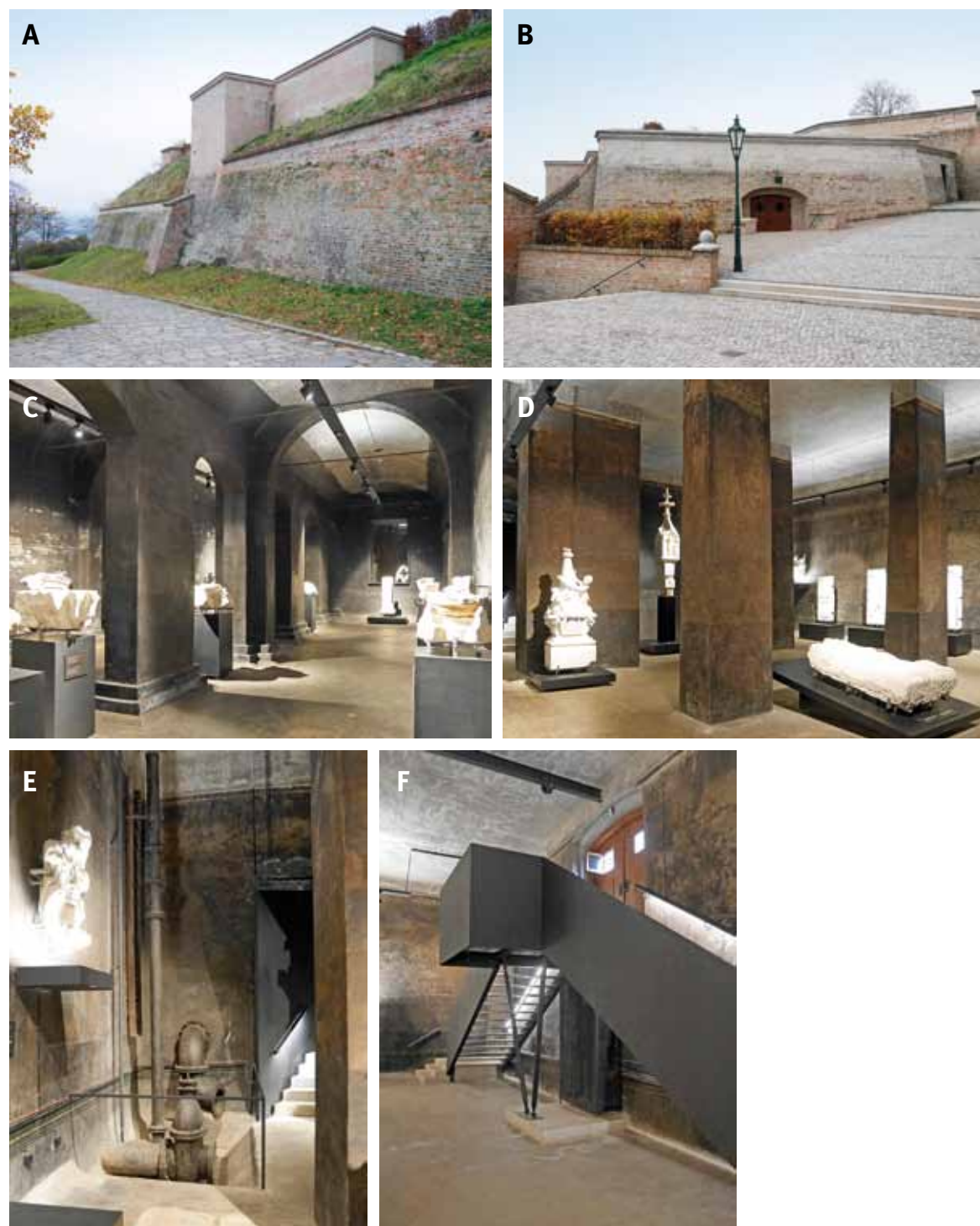
Obr. 5.23: Brno – zemní vodojemy na Špilberku: (A) jihovýchodní bastion hradu Špilberk; (B) nově vybudovaný vstup; (C) lapidárium expozice ve starším vodojemu z let 1870–1871; (D) expozice ve vodojemu z roku 1900; (E) řada původních, dnes již nefunkčních prvků zůstala zachována; (F) nové schodiště. Foto Michaela Ryškové, 2021.
