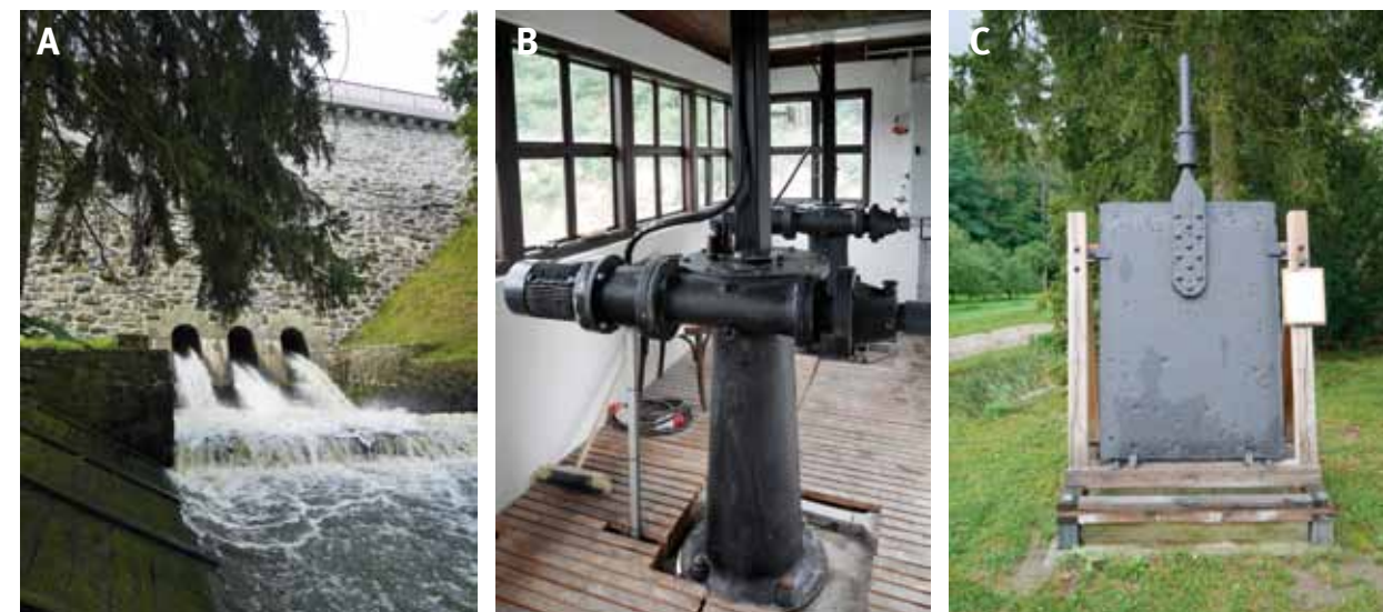
Obr. 4.25: Přehrada Jevišovice (1884–1896) – zděná tížná přehrada. (A) spodní výpusti přehrady, které představují tři štoły; (B) ovládací provozní uzávěry spodních výpusti umístěné na koruně hráze, původně nekryté, teprve dodatečně byl nad ním vybudován objekt; (C) jeden z původních uzávěru výpusti, umístěný dnes pod přehradou. Foto Michaela Ryšková, 2020.
