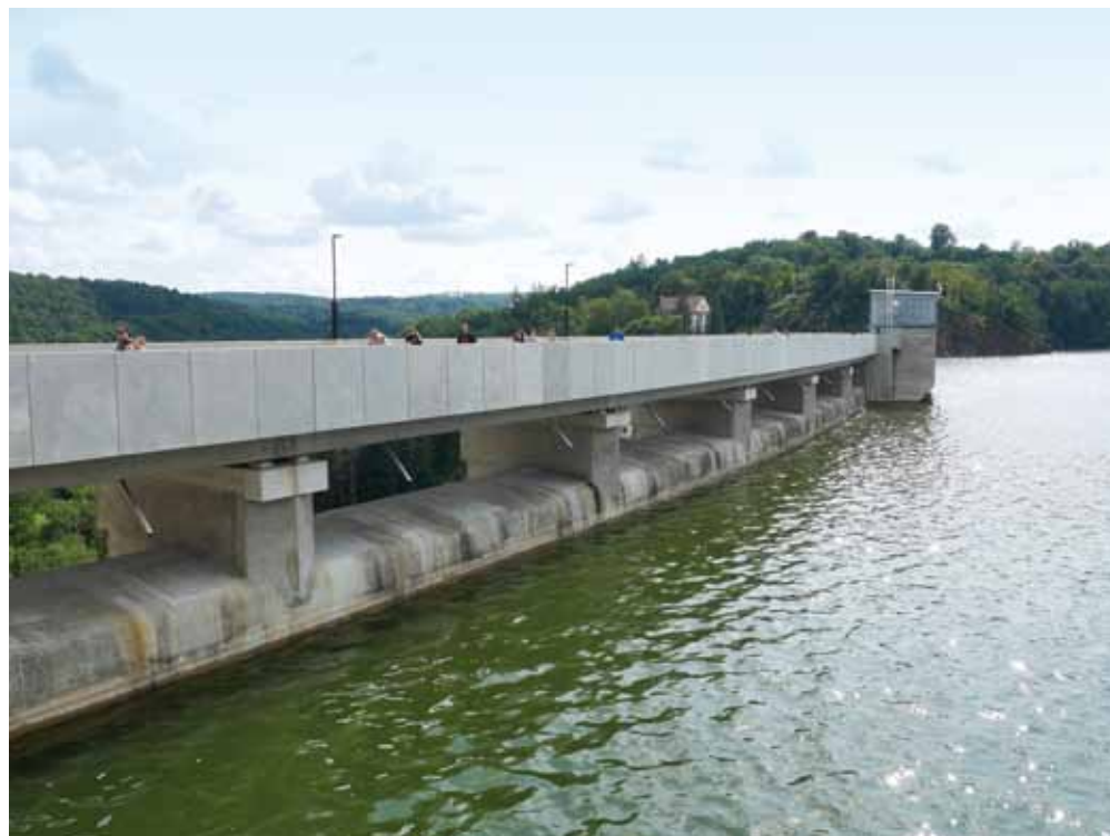
Obr. 4.14: Přehrada Vranov (1930–1934) – ukázka betonové hráze a korunového nehrazeného přelivu. Foto Michaela Ryškové, 2020.
