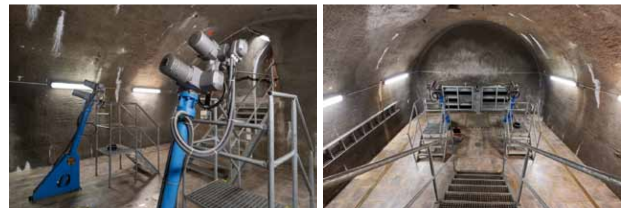
Obr. 4.10: Přehrada Pařížov (1909–1913) – ovládání provozních segmentových uzávěrů spodních výpustí DN1200 uložených v obtokové štole. Foto Viktor Mácha, 2020.
