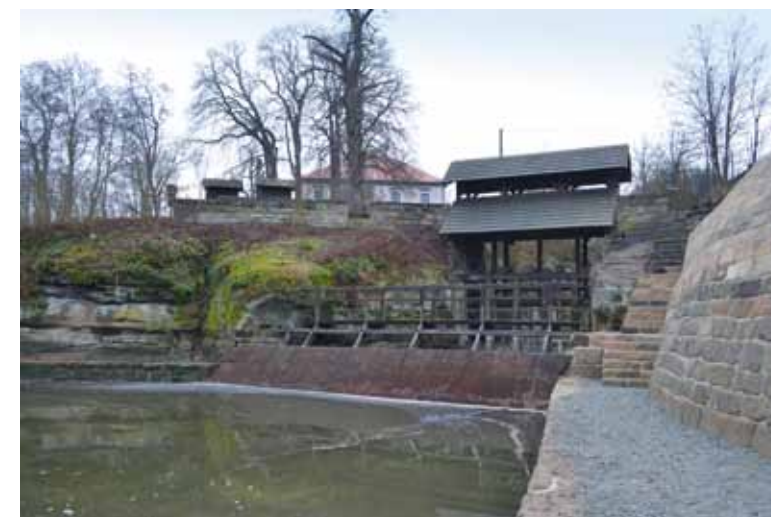
Obr. 4.63: Zahrádky, Novozámecký rybník – výpusť s otevřeným odpadem a masivní stavidlovou trámovou konstrukcí s pochozí lávkou, stříškou a česly, veškeré konstrukce jsou osazeny do dráž ve skalních pískovcových stěnách. Foto Miroslav Kolka, 2015.
