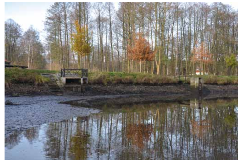
Obr. 4.52: Hradčany, Hradčanský rybník – přímá hráz s hlavní výpustí (opravo) a odtokem do náhonu na zaniklý mlýn (vlevo), stav po vypuštění rybníka. Foto Miroslav Kolka, 2017.
