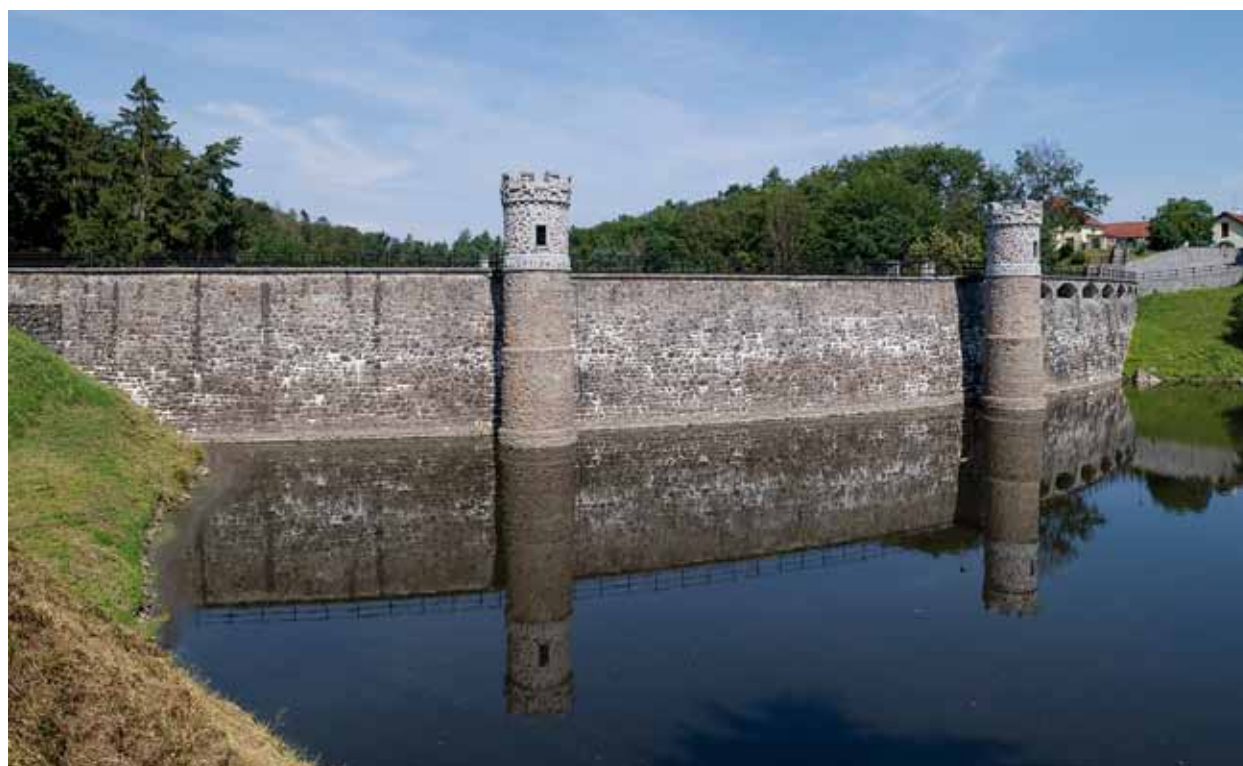
Obr. 4.9: Přehrada Pařížov (1909–1913) – manipulační věže na návodní straně hráze pro ovládání revizních šoupátkových uzávěrů. Foto Viktor Mácha, 2020.
