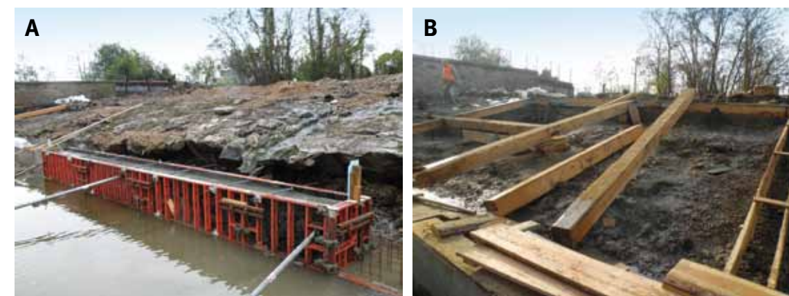
Obr. 5.5: Znojmo-Oblekovice – rekonstrukce jezu v Oblekovicích na řece Dyji: (A) založení nové paty jezu, říjen 2018; (B) výměna trámového rástru jezového tělesa, listopad 2018. Foto Miriam Džuráková, 2018–2019.
