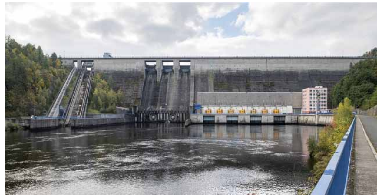
Obr. 4.15: Přehrada Orlík (1954–1963) – tížná betonová přehrada. Foto Viktor Mácha, 2021.
