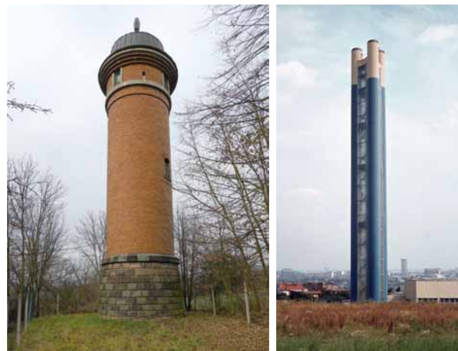
Obr. 4.225: Odlehčovací a vyrovnávací věže vodovodů: (A) Letovice – odlehčovací věž I. březovského vodovodu pro zásobování Brna pitnou vodou; (B) Praha – vyrovnávací věž Děvín postavená podle návrhu arch. Karla Hubáčka, SIAL. Foto (A) Michaela Ryšková, 2016; (B) Archiv PVK, f. Fotoarchív PVK, kt. N 8, sign. B 9516.
