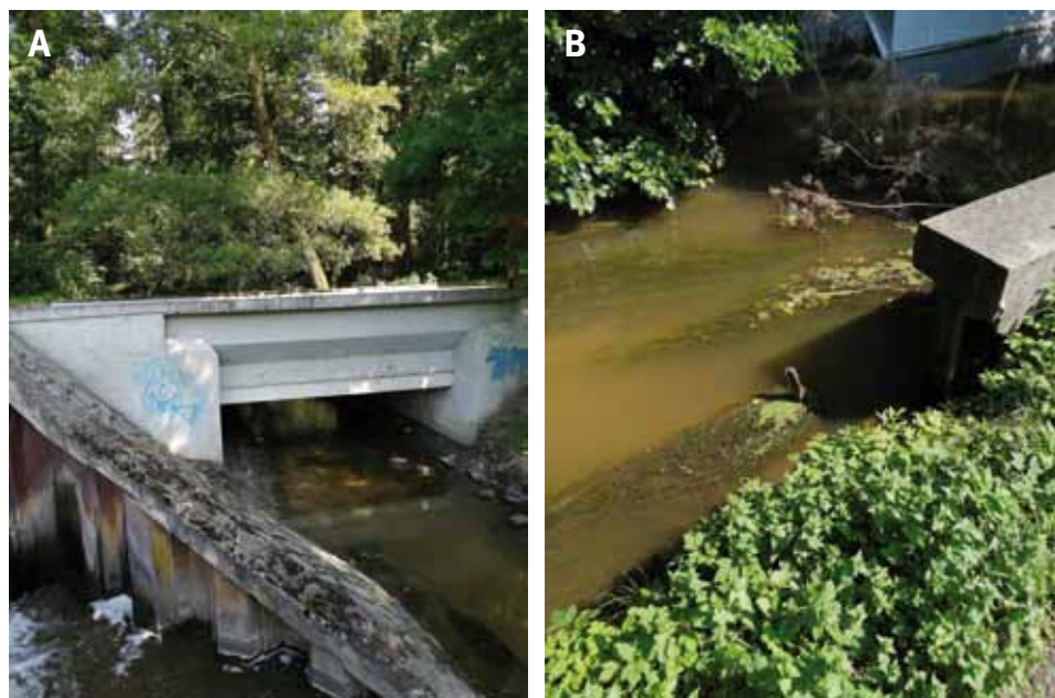
^ Obr. 4.92: Semínský akvadukt na Opatovickém kanále: (A) stav po rekonstrukci; (B) pozůstatky starých dřevěných proků. Foto David Honek, 2020.
