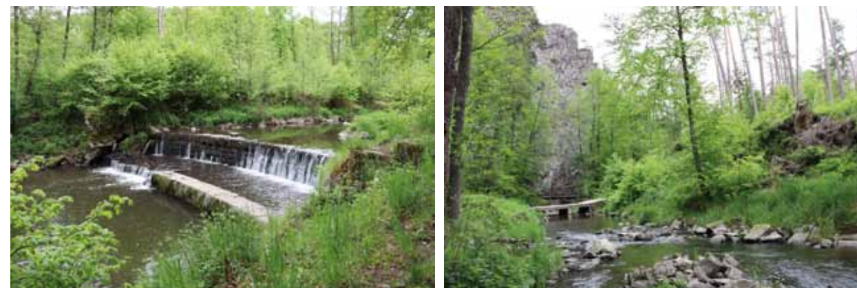
Obr. 5.26: Křemžský potok – vlevo pohled na nejnižší situovaný zachovalý stupeň. Vpravo pohled na jeden z novodobých mostků – betonové prefabrikáty. Foto J. Hansová, 2021.
