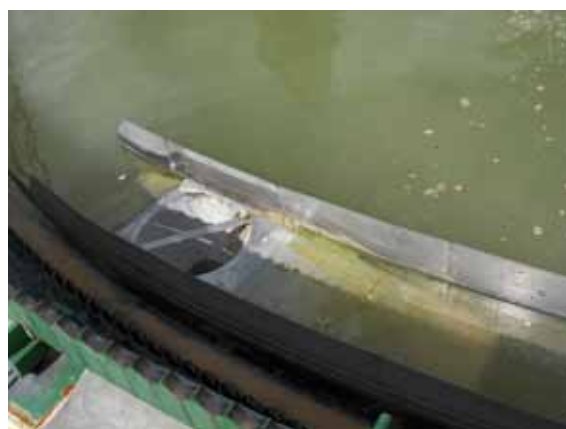
Obr. 4.245: Přelivná hrana. Foto archiv VÚV.
