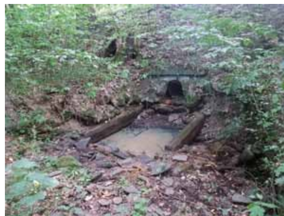
Obr. 4.62: Zbýšov (okres Kutná Hora) – spodní výpusť zaniklého Nového rybníka s dochovanými relikty podtrubní jámy a vývaru. Foto Jindřich Frajer, 2020.
