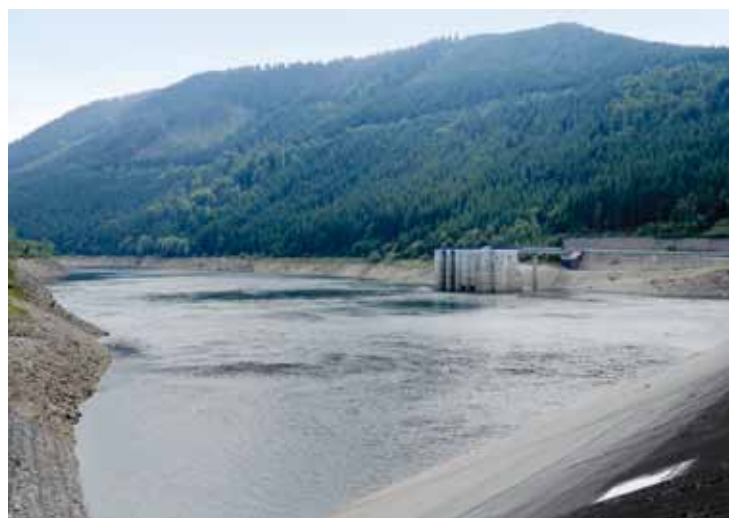
Obr. 4.147: PVE Dlouhé stráně – dolní nádrž. Foto Michaela Ryškové, 2019.
