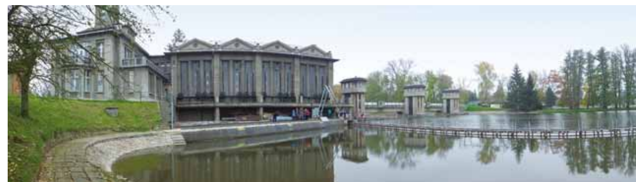
Obr. 4.129: MVE Poděbrady – vtokový objekt. Foto VUT v Brně, FAST, 2014.
