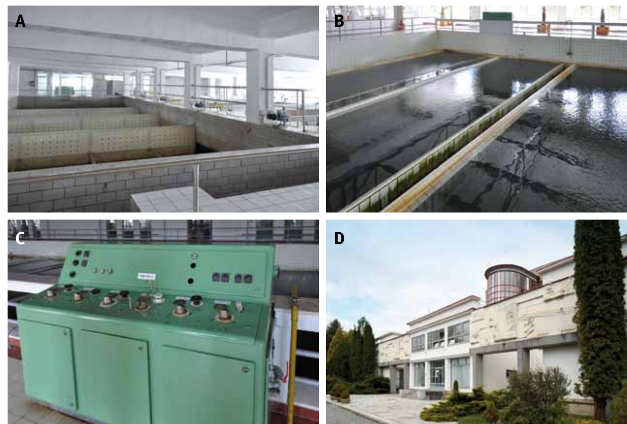
Obr. 4.232: Vítkov-Podhradí – úpravna vody: (A) hala filtrace; (B) filtrační nádrže; (C) původní ovládací panel; (D) průčelí s reliéfem (více fotografií v kapitole 3.2, hodnota umělecko-historická). Foto (A) – (C) David Honek, 2019; (D) Roman Polášek, 2019.
