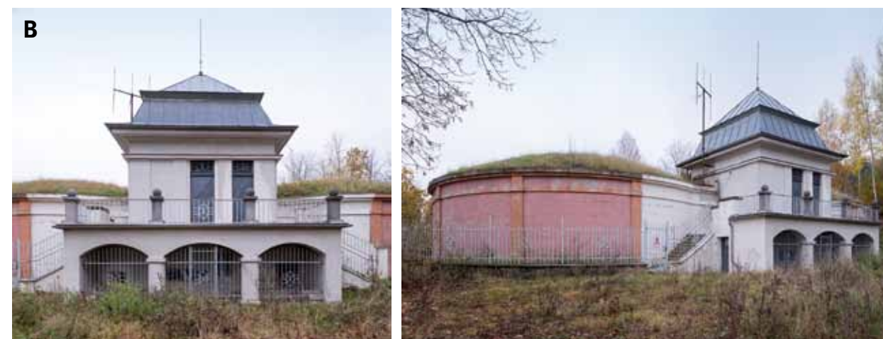
Obr. 4.215: Zemní vodojemy: (A) Olomouc – zemní vodojem na Tabulovém vrchu z roku 1889, vystavený spolu s 8 km vzdálenou parní čerpací stanicí v Chvoálkovicích; (B) Příbram – zemní vodojem Husa / U Husy, dokončený kolem roku 1930, jímá vodu z dolu Drkolnov. Foto (A) Michaela Ryškové, 2022; (B) Viktor Mácha, 2019.
