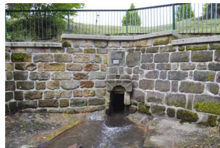
Obr. 4.65: Hamr na Jezeře, Hamerský rybník – vřadní líc hráže s vyústěním spodní výpusti, datováno 1821, stav po novodobých úpravách zdiva. Foto Miroslav Kolka, 2017.
