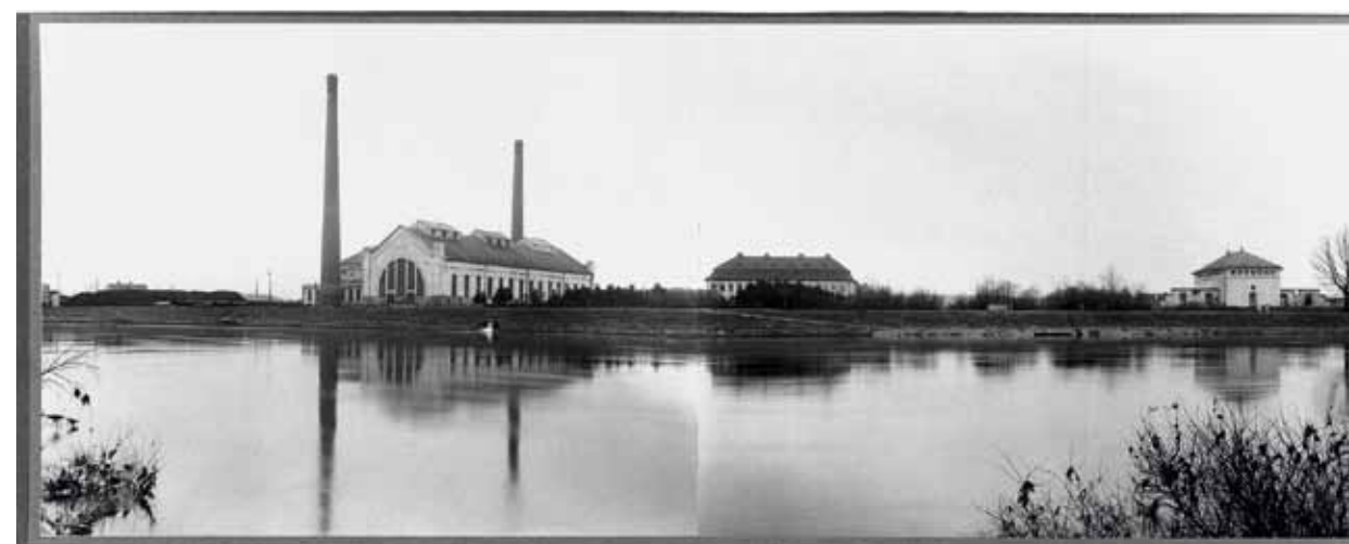
Obr. 4.202: Káraný, Káraná vodárna – vodárna v obci Káraný na soutoku Labe a Jizery, byla postavena v letech 1896 až 1912, spuštěna 1913, oficiálně 1. ledna 1914. Vodárna je založena na jímání podzemní vody, která vzniká prosakováním říční vody do vhodného, zde štěrko-pískového podloží. Přirozeně profiltrovaná voda je sbírána podzemními nasávacími studněmi. V 60. letech byl proces doplněn umělou infiltrací, spojenou s přímým čerpáním surové vody z řeky na soustavu venkovních pískových filtrů. Vedlejším zdrojem vody je taktéž soustava artézských studní. Původně byla poháněna parními stroji, od 30. let 20. století modernizována na elektrický pohon. Vodárna je stále plně funkční. Od začátku se jednalo o lokální skupinový vodovod, protože původními odběrateli bylo hl. město Praha a jeho předměstí, od druhé poloviny 20. století je na vodu napojena i řada okolních obcí podél hlavního přivaděče. Foto: Archiv PVK, Fotoarchiv, kt. N 21, sign. C 083a.
