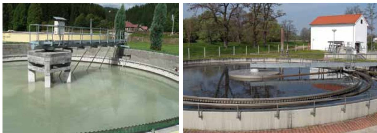
Obr. 4.244: Radiální usazovací nádrž. Foto archiv VÚV.
