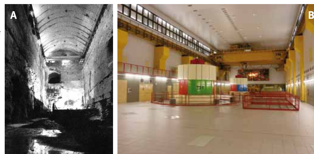
Obr. 4.162: PVE Štěchovice se strojovnou šachtového typu. Foto VUT v Brně, FAST, 2019.
