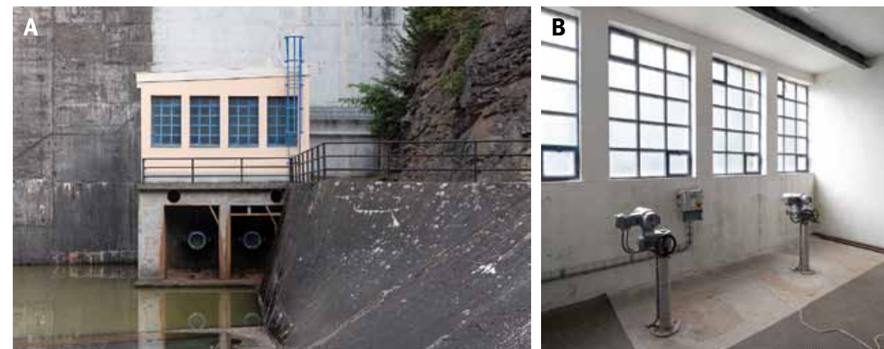
Obr. 4.24: Přehrada Vrchlice (1966–1970) – klenbová přehrada: (A) provozní rozstříkovací uzávěry spodních výpusti; (B) ovládací zařízení rozstříkovacích uzávěru. Foto Viktor Mácha, 2020.
