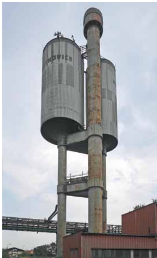
Obr. 4.222: Ostrava-Vitkovice – ocelový věžový vodojem se dvěma nádržemi, vystavěný jako součást průmyslového areálu. Typologicky, konstrukčně i parametricky se vymykal dobové produkci. Konstrukční pojetí bylo odlišné od běžně budovaných ocelových věžových vodojemů z produkce Vítkovických železáren (např. vodojemů v Ostravě-Hladnově). Unikátní bylo nesení každé nádrže samostatným dřívkem a výtahová šachtice umístěná ve třetím, samostatném dřívku, což je doloženo v ČR pouze ve třech případech. Zároveň šlo o jeden z věžových vodojemů s největším objemem v ČR. Ve 3. celostátní soutěži ČSVTS o nejlepší stavbu s nosnou ocelovou konstrukcí získal za rok 1983 hlavní cenu v kategorii Technologické konstrukce. Projektovou a předvýrobní přípravu zajistil Hutní projekt Praha, závod Ostrava (generálním projektantem byl Ing. Ant. Kozák) a VŽKG, k. p., Ostrava (nádobu projektoval Pavel Klimeš) (Devátý, 1983, Soušek, 1982). Vodojem byl zároveň pohledovou dominantou a významným orientačním bodem Vítkovic. Byl zbořen v roce 2022. Foto Michaela Ryškové, 2016.
