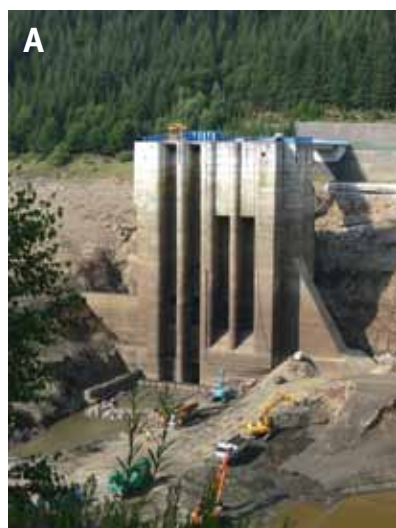
Obr. 4.146: PVE Dlouhé stráně, dolní nádrž – věžový vtokový objekt (sdružený – obsahuje i spodní úpusti a bezpečnostní přelivy): (A) stav při vypuštěné nádrži; (B) řez: 1 – strojovna segmentů hrazení bezpečnostních přelivů, 2 – most, 3 – zásyp, 4 – česle nebo provizorní hrazení (hradidla), 5 – tabulový uzávěr, 6 – torkret, 7 – těsnění dilatační spáry. Foto VUT v Brně, FAST; schéma Radka Račoch a Michaela Mroová, 2021 (upraveno dle: Hynková, 1984).
