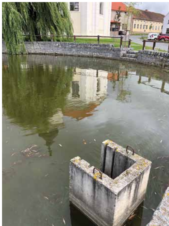
Obr. 4.62: Zbýšov (okres Kutná Hora) – spodní výpusť zaniklého Nového rybníka s dochovanými relikty podtrubní jámy a vývaru. Foto Jindřich Frajer, 2020.
