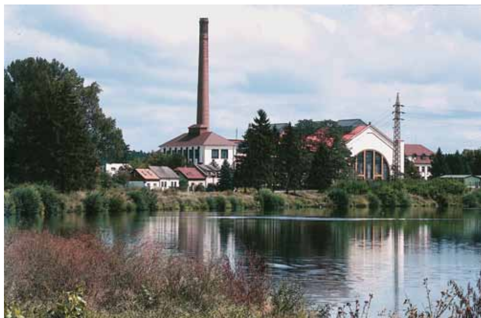
Obr. 4.228: Káraný – celkový pohled na úpravnu vody Káraný. Foto Archiv PVK, f. Fotoarchív PVK, digitální archiv, sign. DV 125.
