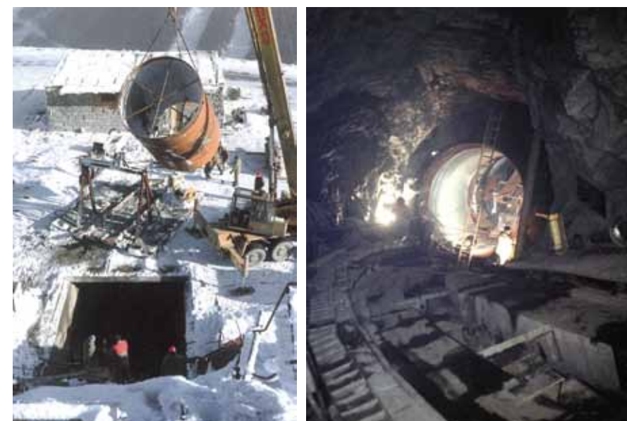
Obr. 4.151: PVE Dlouhé stráně – ukládání ocelového pancíře do přívodní štoly k turbínám (převzato z: Hóll, 1997).
