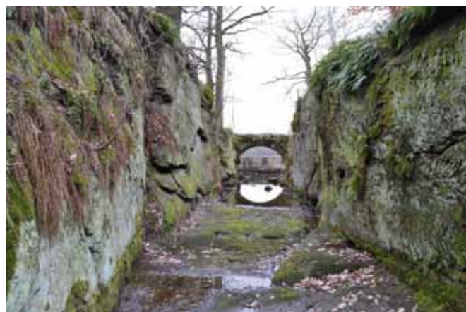
Obr. 4.67: Stvolínky, Dolanský rybník – skalní průruva bezpečnostního přelivu, v pozadí most v trase hráze. Foto Miroslav Kolka, 2016.
